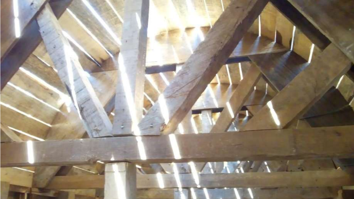
Figura 32. Cimbrado de la bóveda respetando la geometría de proyecto.
