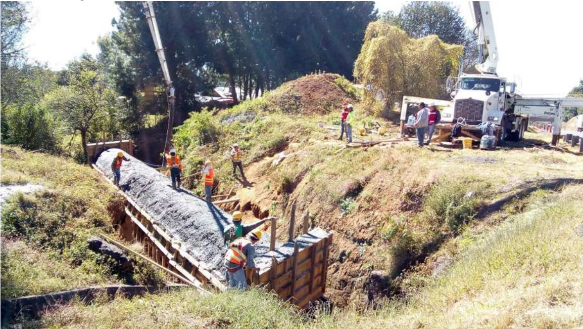
Figura 39. Colado de bóveda.
