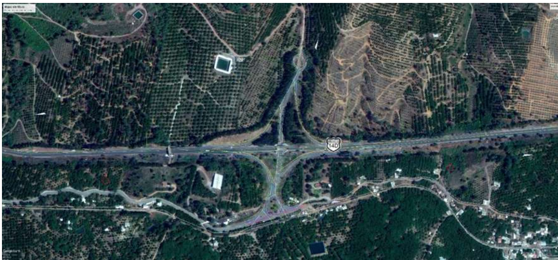
Figura 23. Se muestra trazo definitivo para entronque Jujucato, el cual está aprobado por la SCT. En el cual como se puede observar se afectan todas las gazas.
