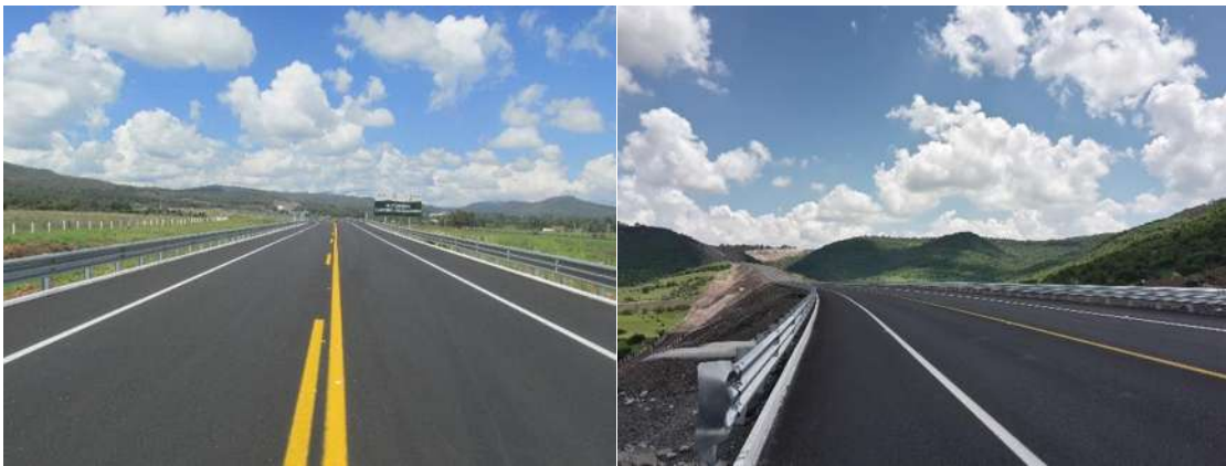
Figura 13. Se muestran los bordillos construidos en ambos lados en un tramo tangente y la construcción de bordillo sobre el lado interior de una curva, como complemento a la definición anterior.
