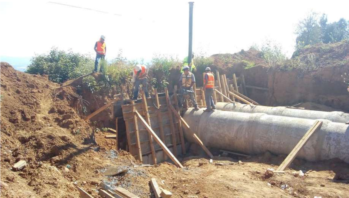
Figura 75. Se realiza el habilitado de la malla de acero, cimbrado y colado de cabezote (vista lateral).
