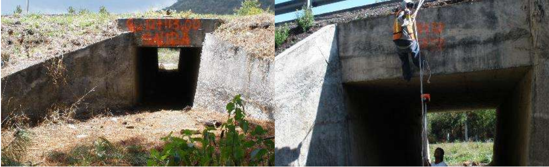
Figura 7. Se muestra cajón de concreto hidráulico sobre cuerpo existente, como complemento a la definición anterior.
