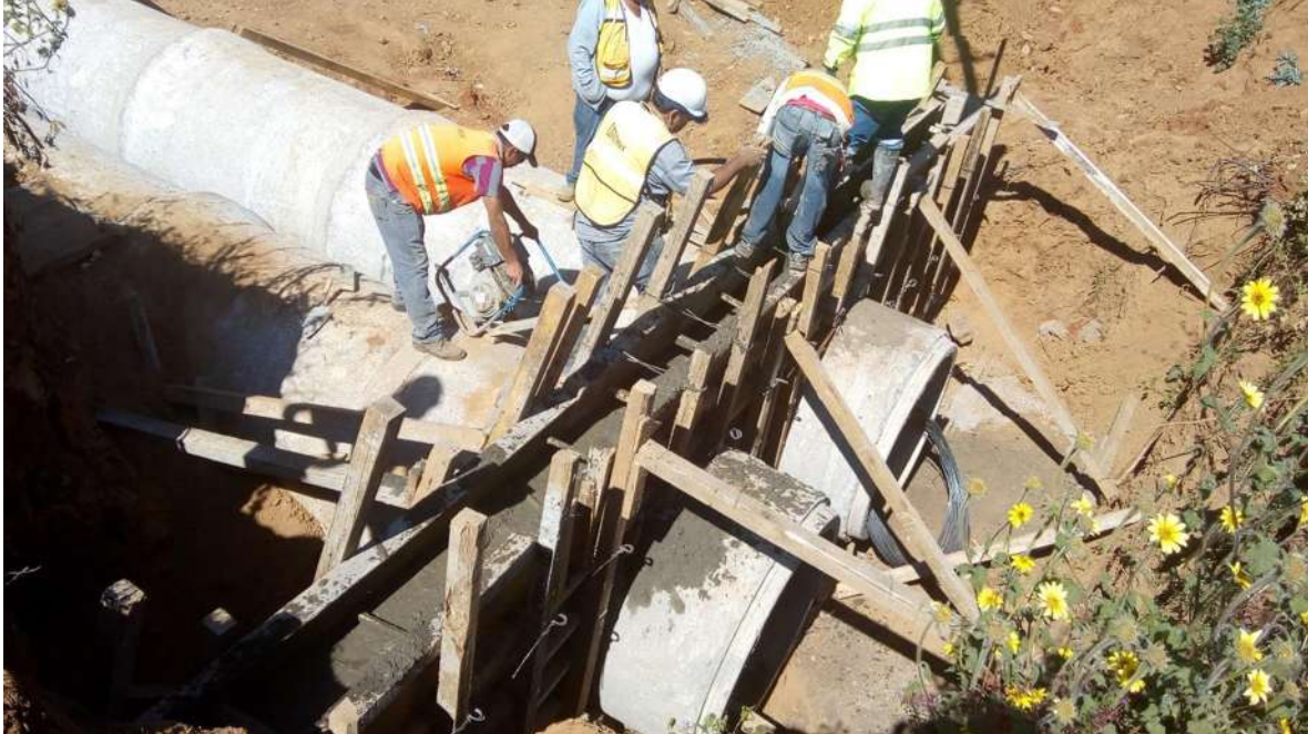
Figura 76. Colado del cabezote
