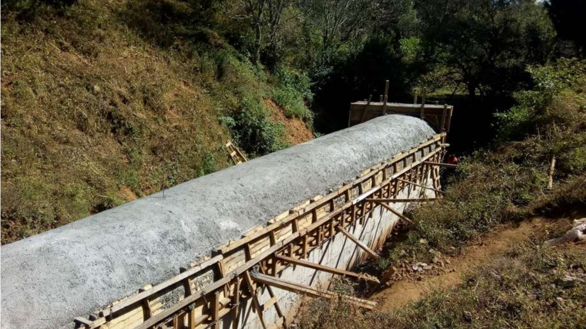
Figura 40. Curado de la losa al terminar el colado de concreto hidráulico-
