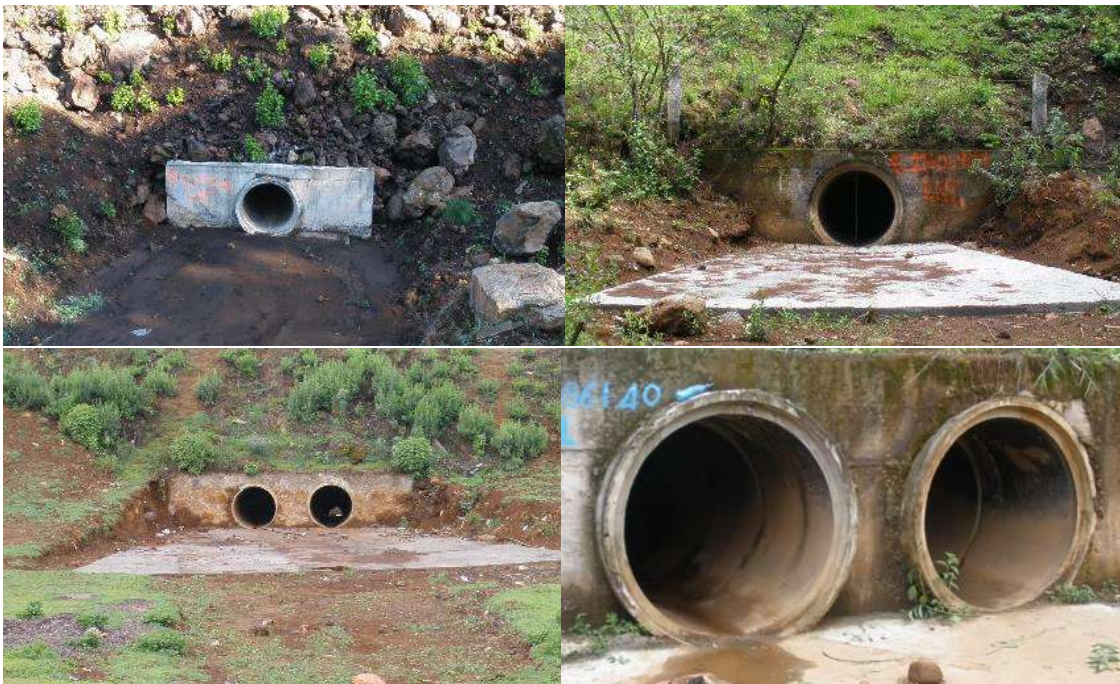
Figura 3. Se pueden observar los tubos de concreto en cuerpo existente, como ilustración a la definición de tubulares de concreto.
