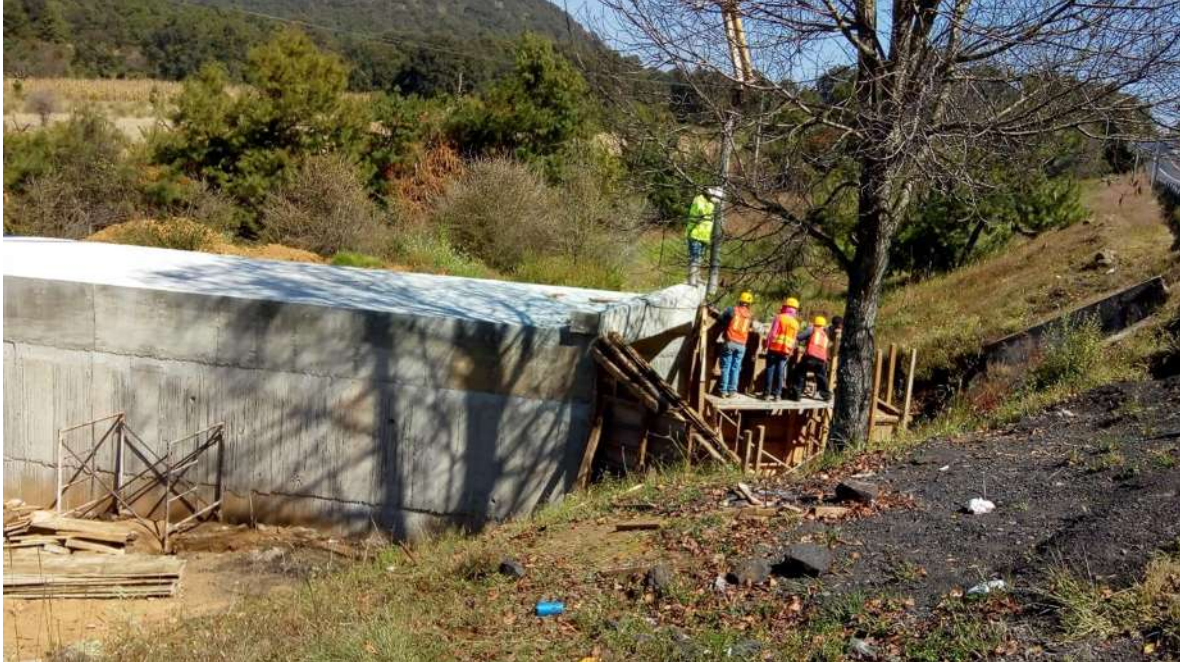
Figura 67. Colado de aleros nuevos sobre aleros existentes.
