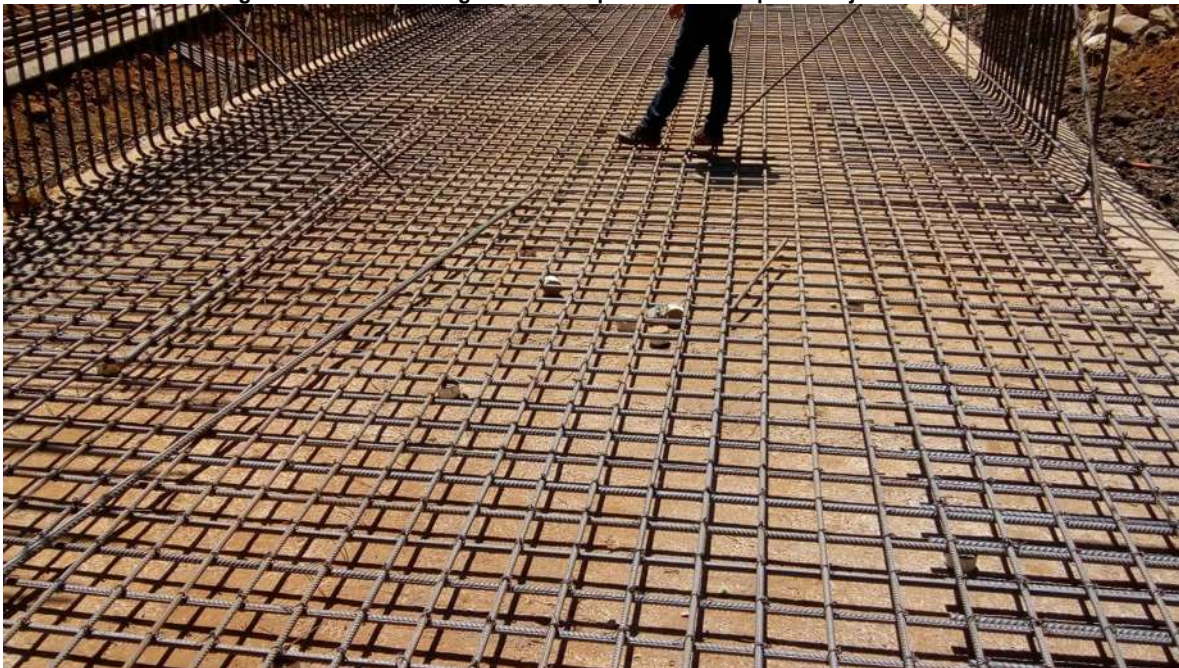
Figura 54. Colado de plantilla y habilitado de acero en parrilla de losa inferior.
