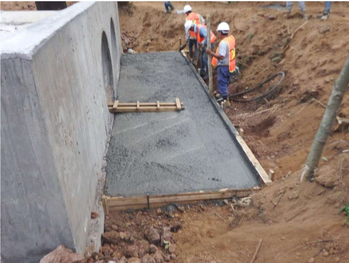
Figura 79. Colado del delantal aguas abajo.
