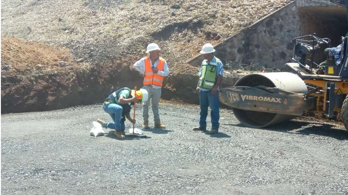
Figura 53. Revisión del grado de compactación en capa de mejoramiento.
