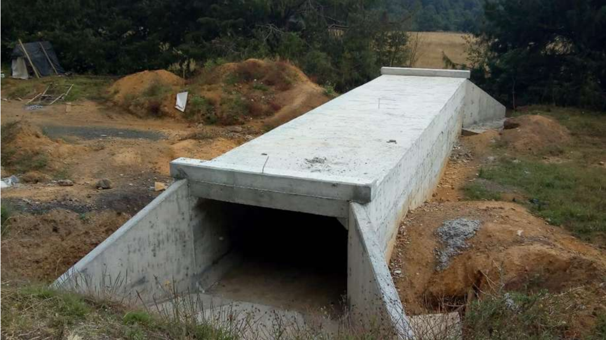
Figura 69. Vista de la obra de drenaje tipo cajón terminada.
