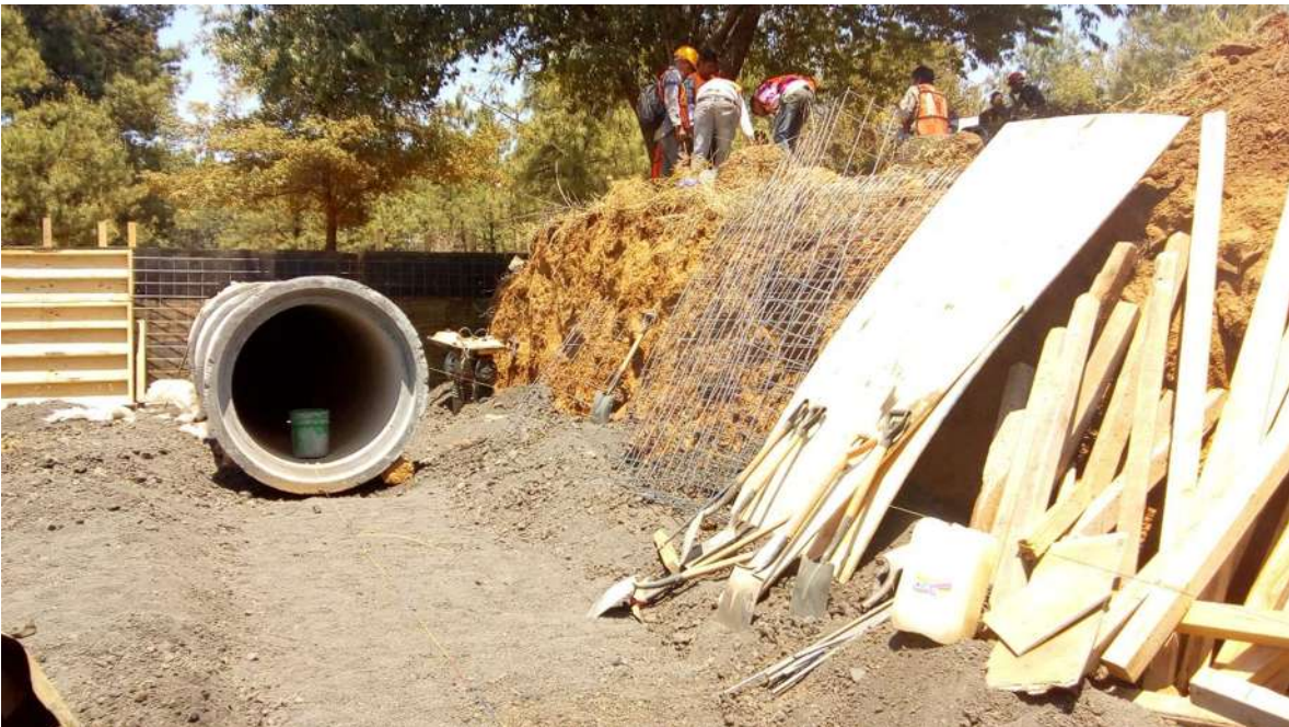
Figura 73. Suministro y colocación de tubos de concreto de acuerdo a lo indicado en el proyecto., sobre la cama de arena.
