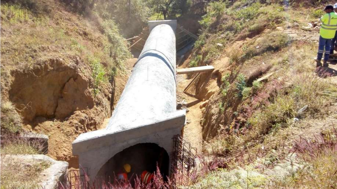
Figura 42. Habilitado de acero en aleros nuevos con liga a los aleros existentes.
