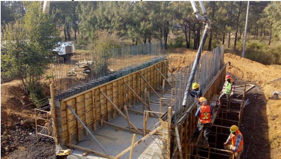
Figura 58. Colado de muros laterales.
