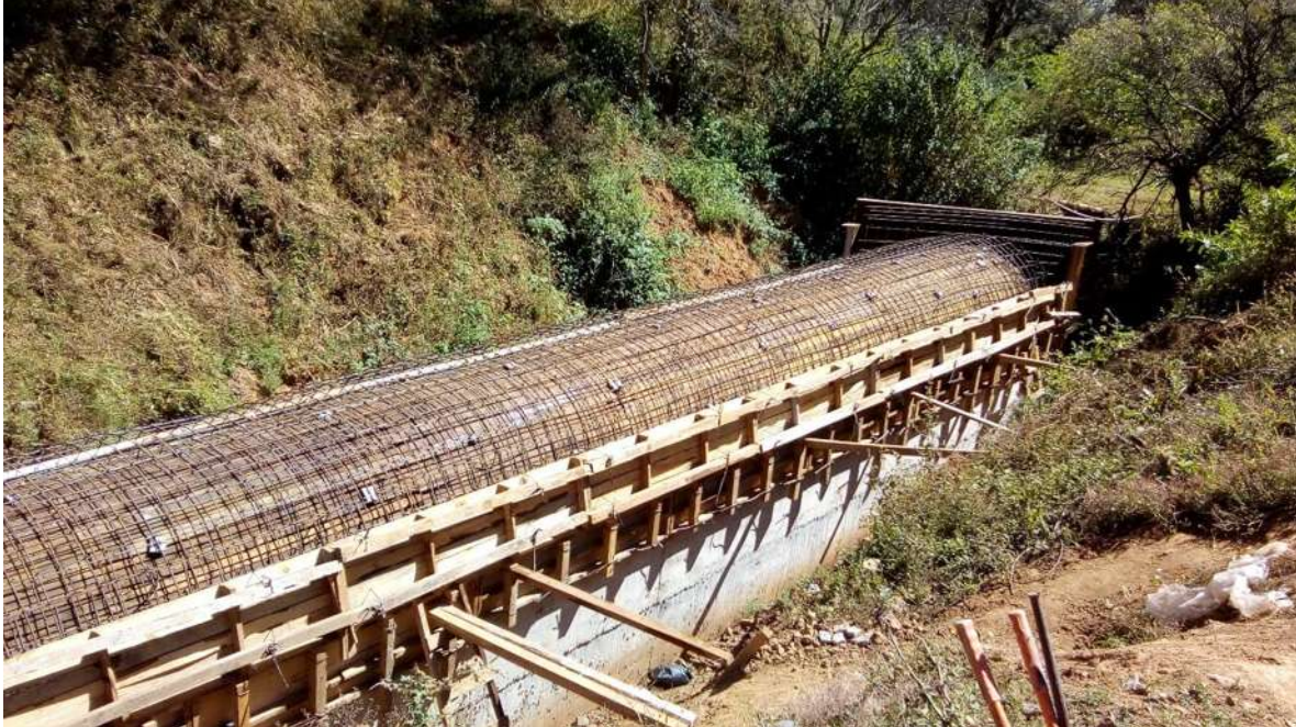
Figura 34. Habilitado de acero.
