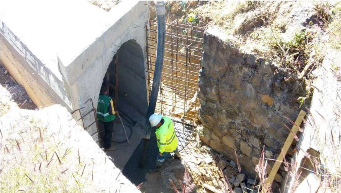
Figura 45. Colado de zampeado de concreto.
