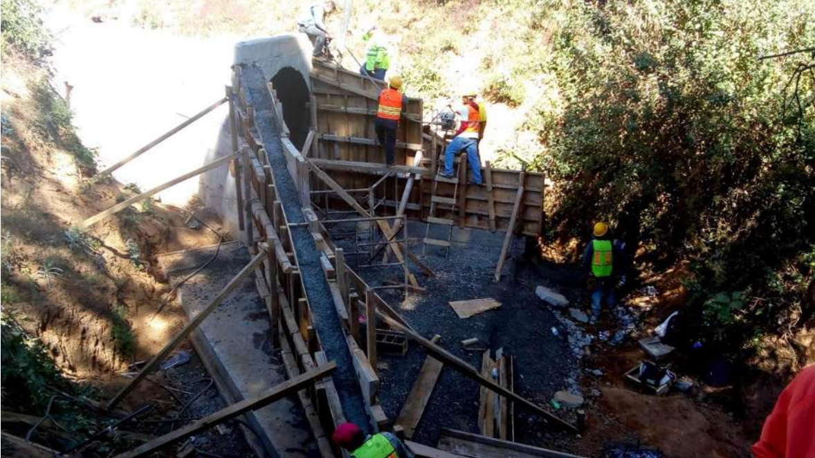
Figura 44. Colado de aleros aguas abajo.
