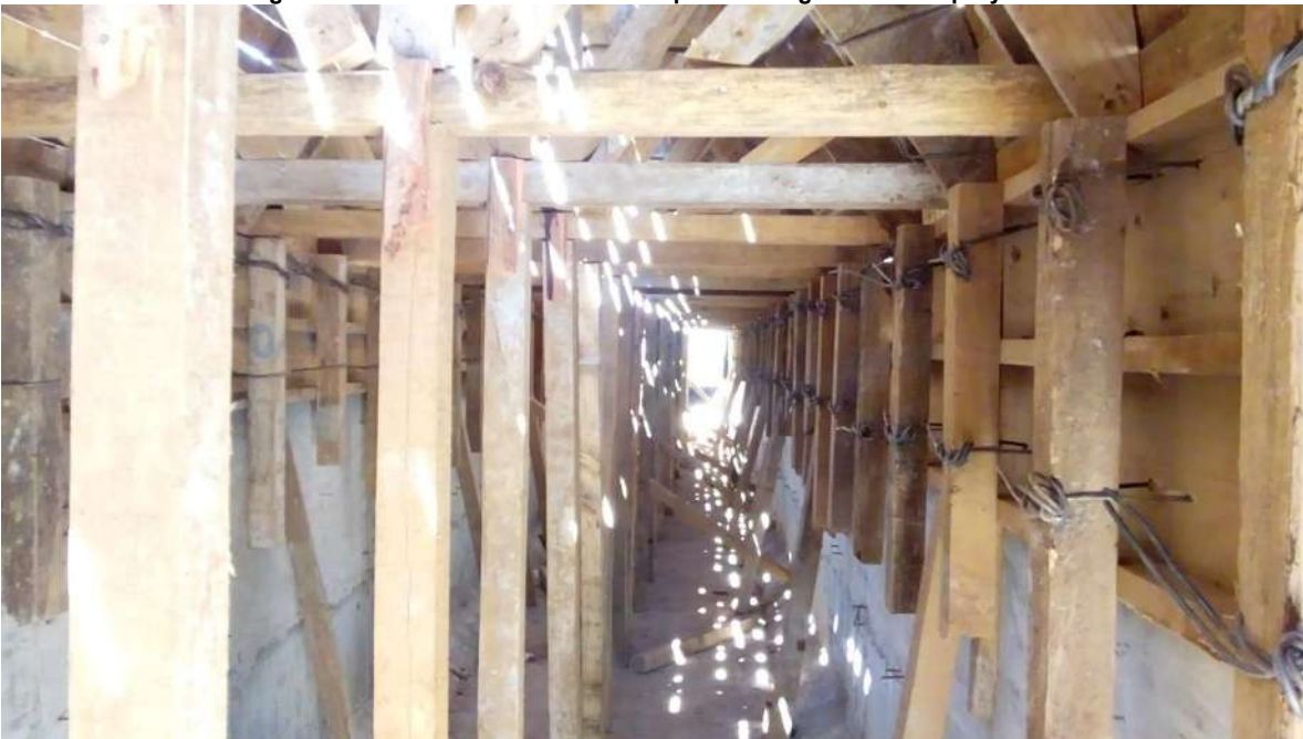
Figura 33. Cimbrado de la bóveda respetando la geometría de proyecto.
