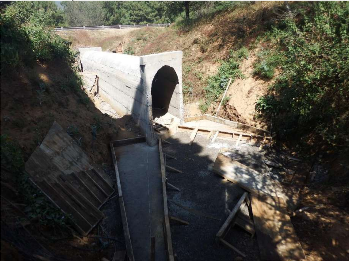
Figura 41. Descimbrado de bóveda, e inicio del habilitado y cimbrado de aleros aguas abajo.
