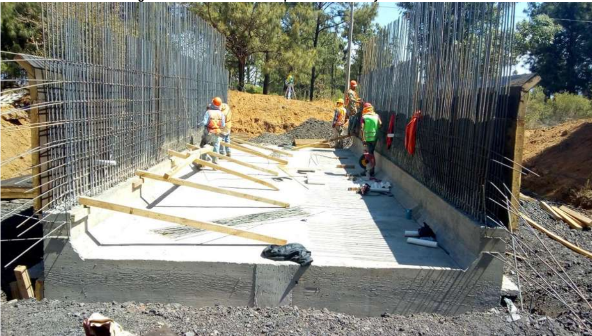
Figura 56. Colado de losa inferior, y detalle de junta fría tipo machimbrado entre losa inferior y muros laterales.
