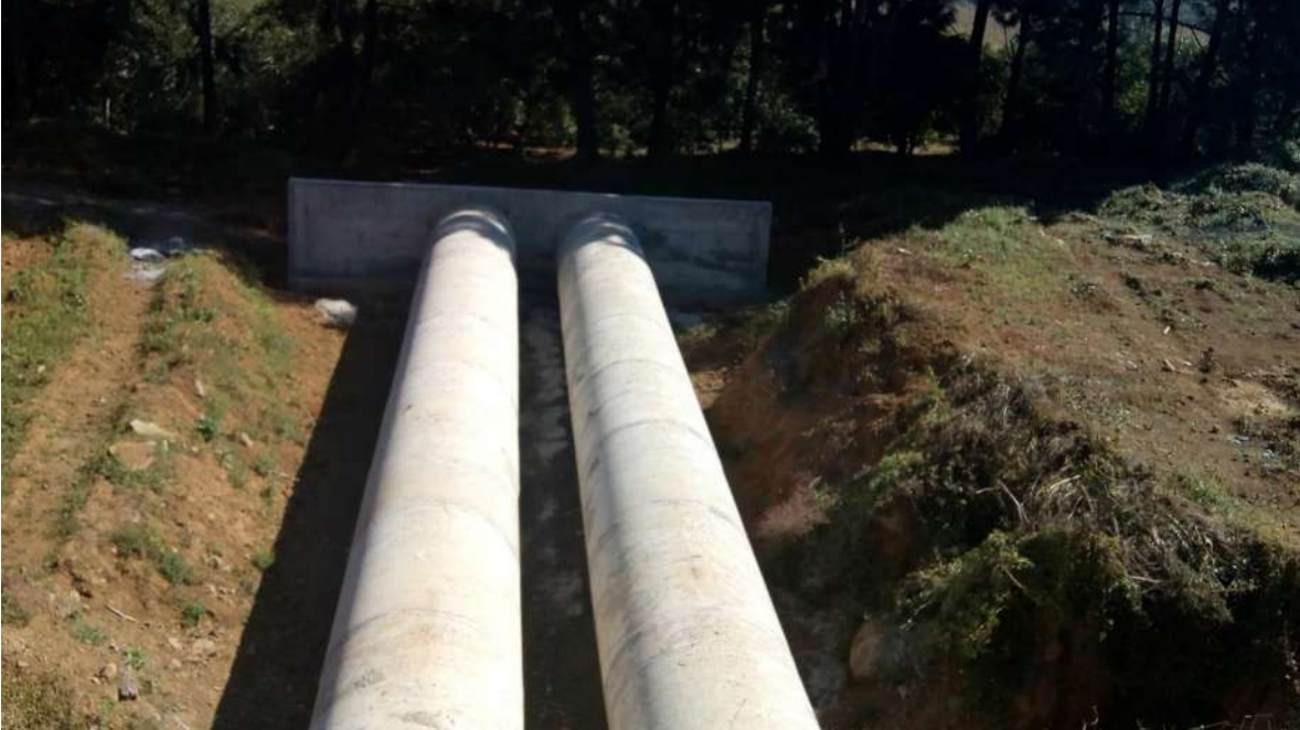
Figura 78. Descimbrado de cabezote en vista anterior.
