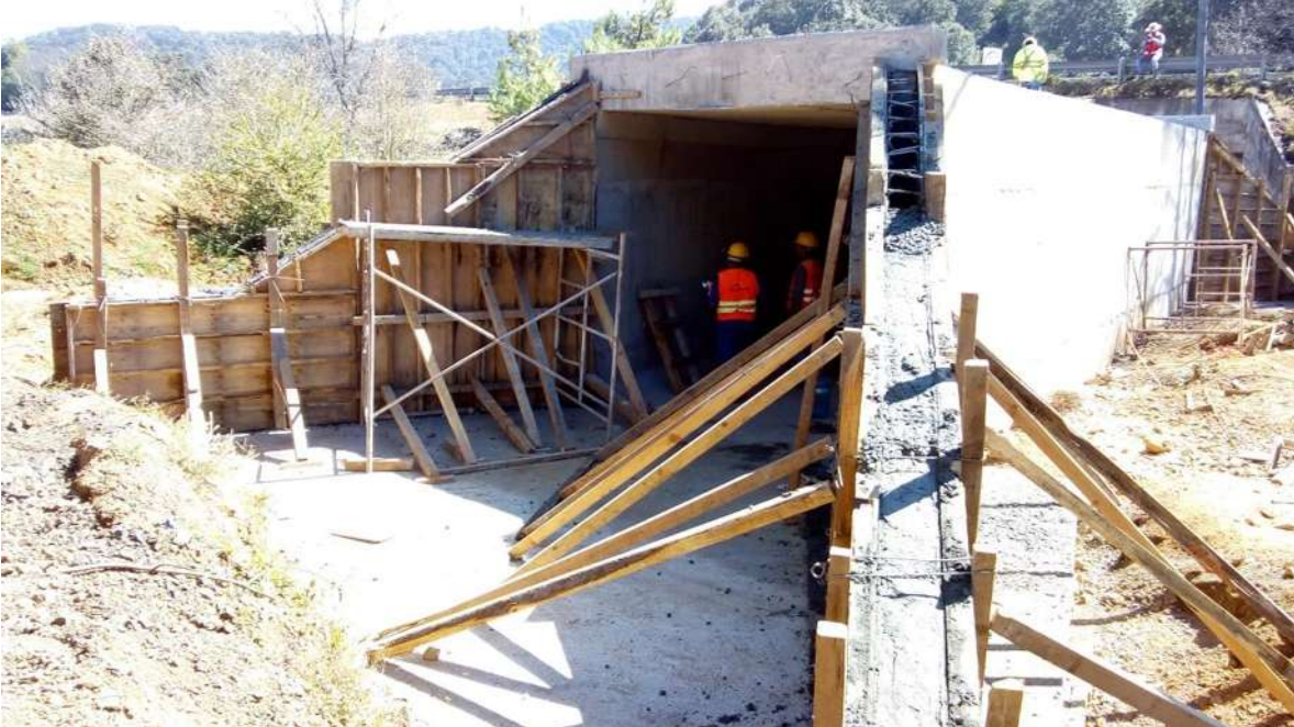
Figura 65. Colado de aleros nuevos sobre aleros existentes.
