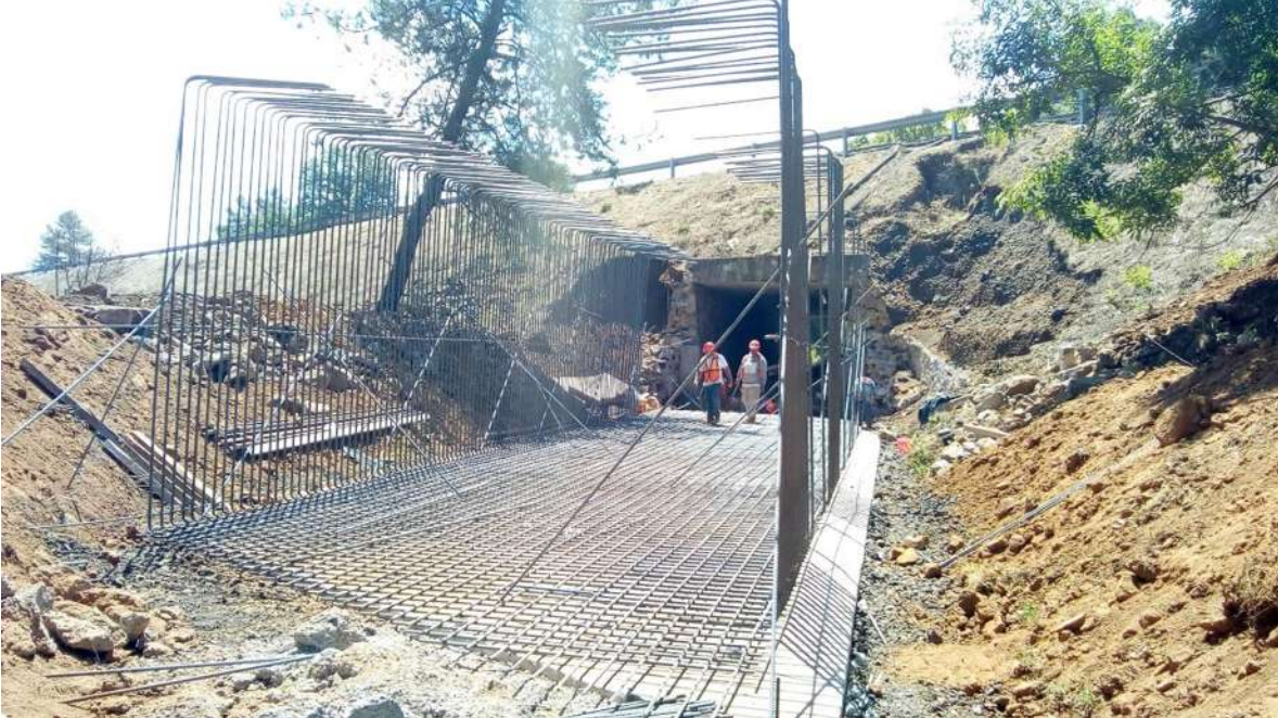
Figura 55. Habilitado de acero para losa inferior y muros laterales.
