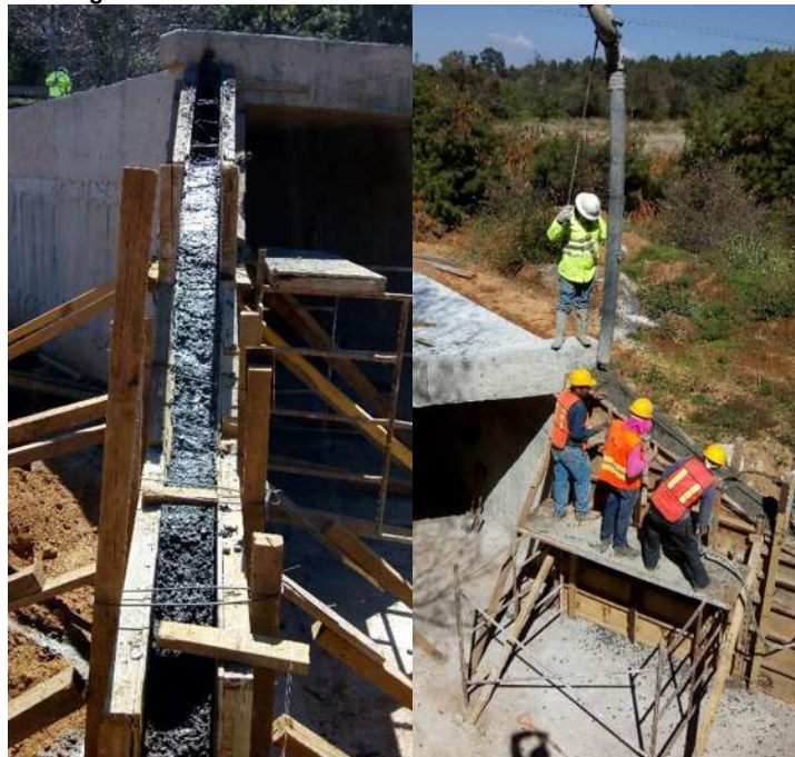
Figura 66. Colado de aleros nuevos con liga a los aleros existentes.
