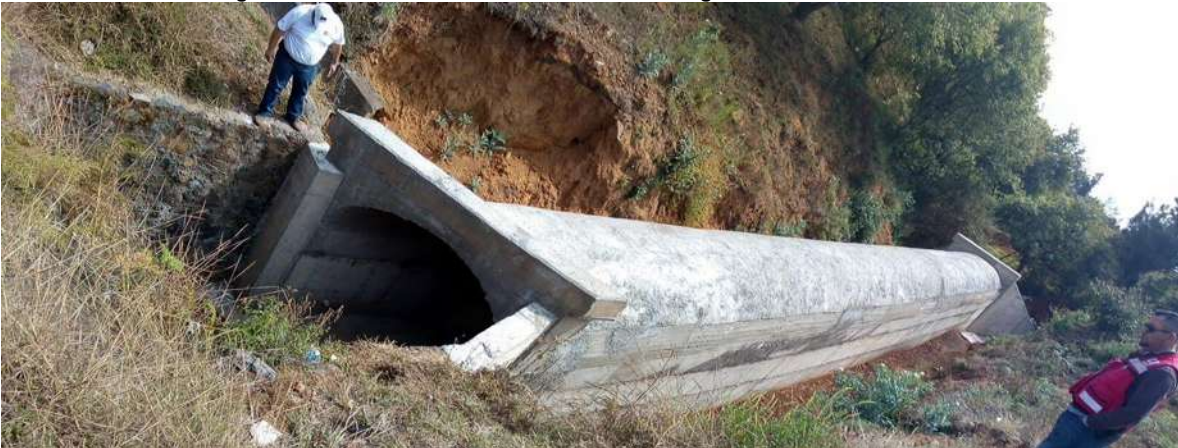
Figura 49. Vista aguas arriba de la bóveda de concreto terminada.
