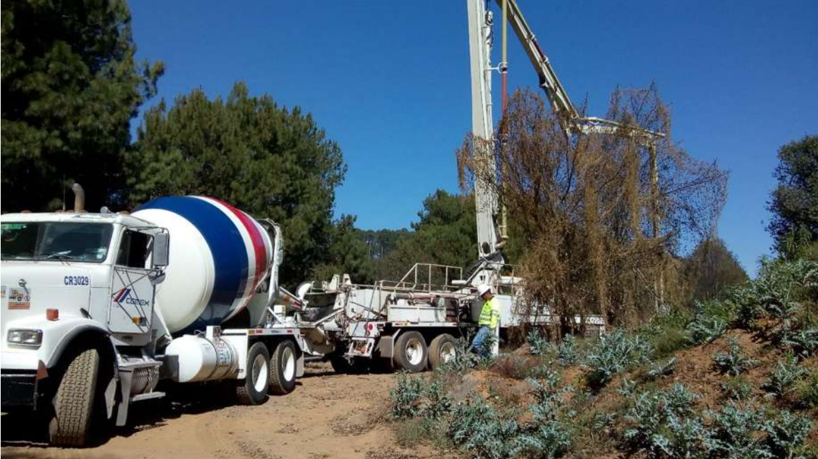
Figura 36. Colado de bóveda.
