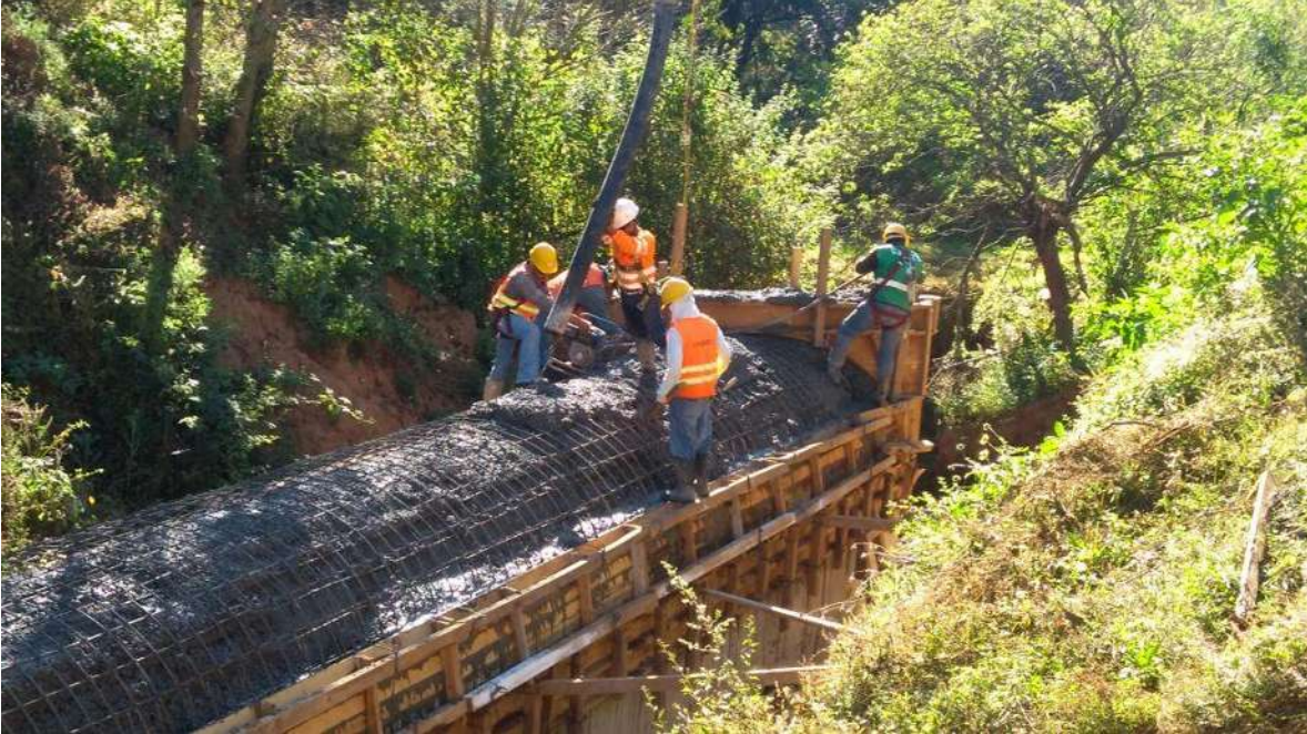
Figura 38. Colado de bóveda, mediante bombeo con un concreto de revenimiento 14 cm.
