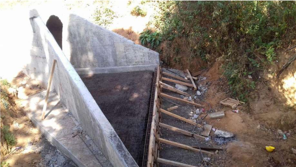
Figura 47. Habilitado de malla electrosoldada y cimbrado para colado de zampeado de concreto aguas abajo.
