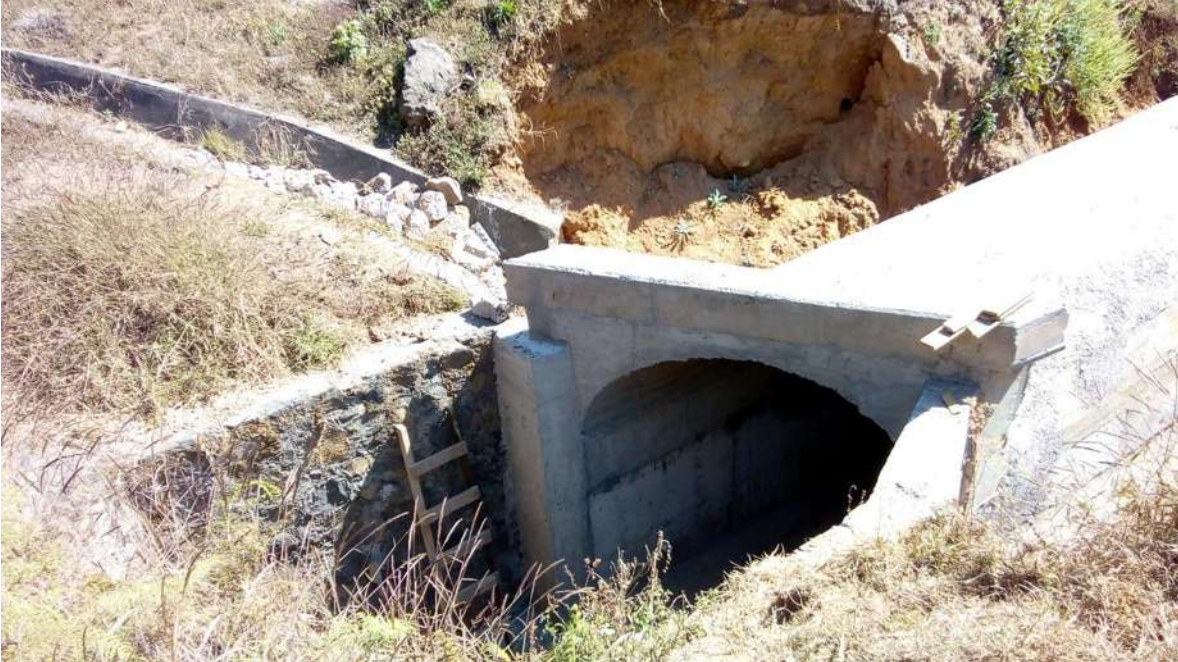
Figura 48. Descimbrado de aleros nuevos con liga a los aleros existentes.
