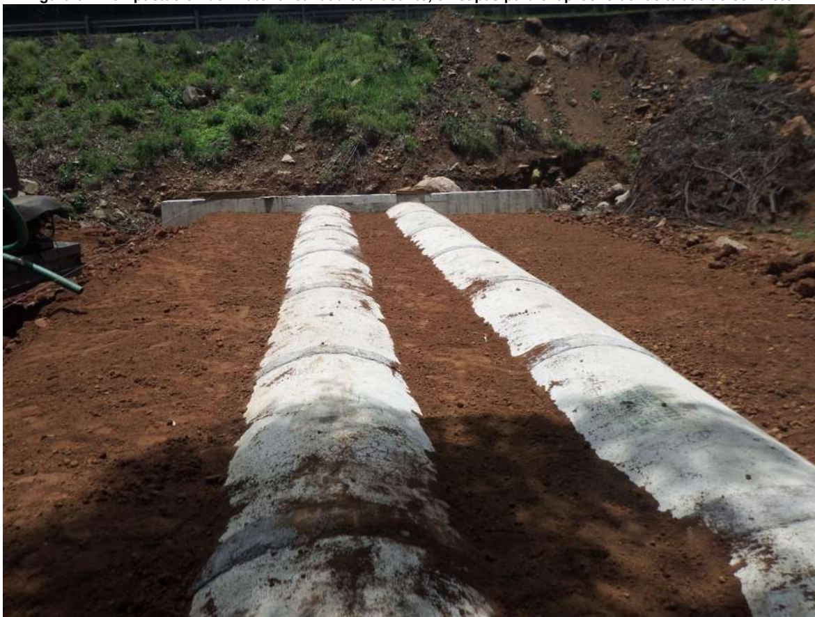
Figura 83. Tubos de concreto aprochados con material de calidad subrasante.
