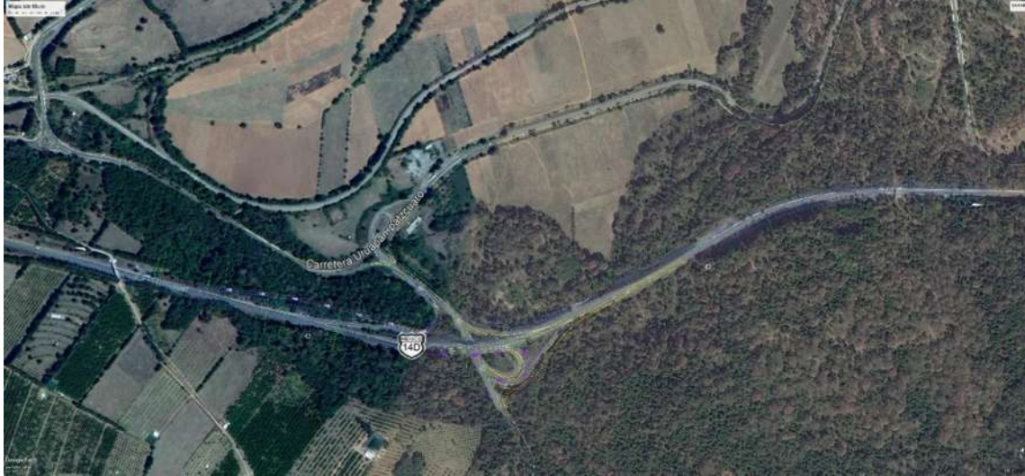
Figura 22. Se muestra el trazo definitivo para entronque Zirahuen, el cual está aprobado por la SCT. En el cual se cómo se puede observar se afectan todas sus gazas.
