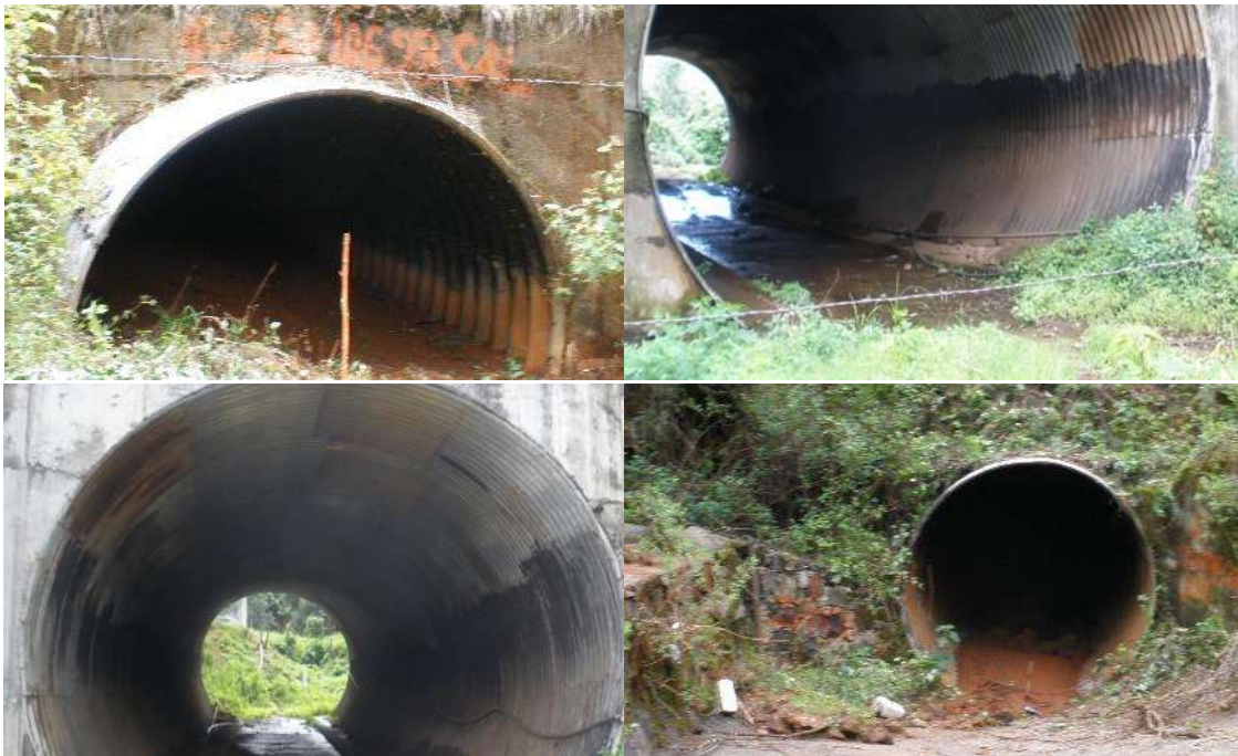
Figura 4. Se muestran tubos de lámina sobre cuerpo existente, como parte de su definición.
