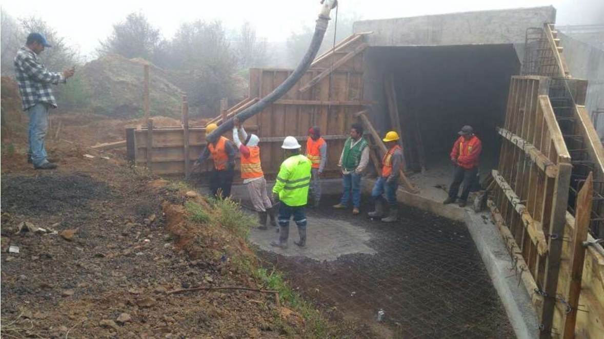
Figura 63. Colado de aleros.
