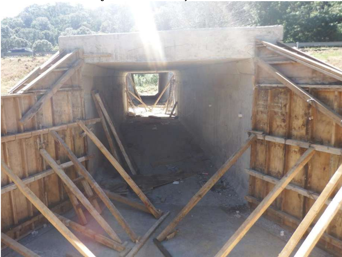
Figura 62. Cimbrado de aleros.
