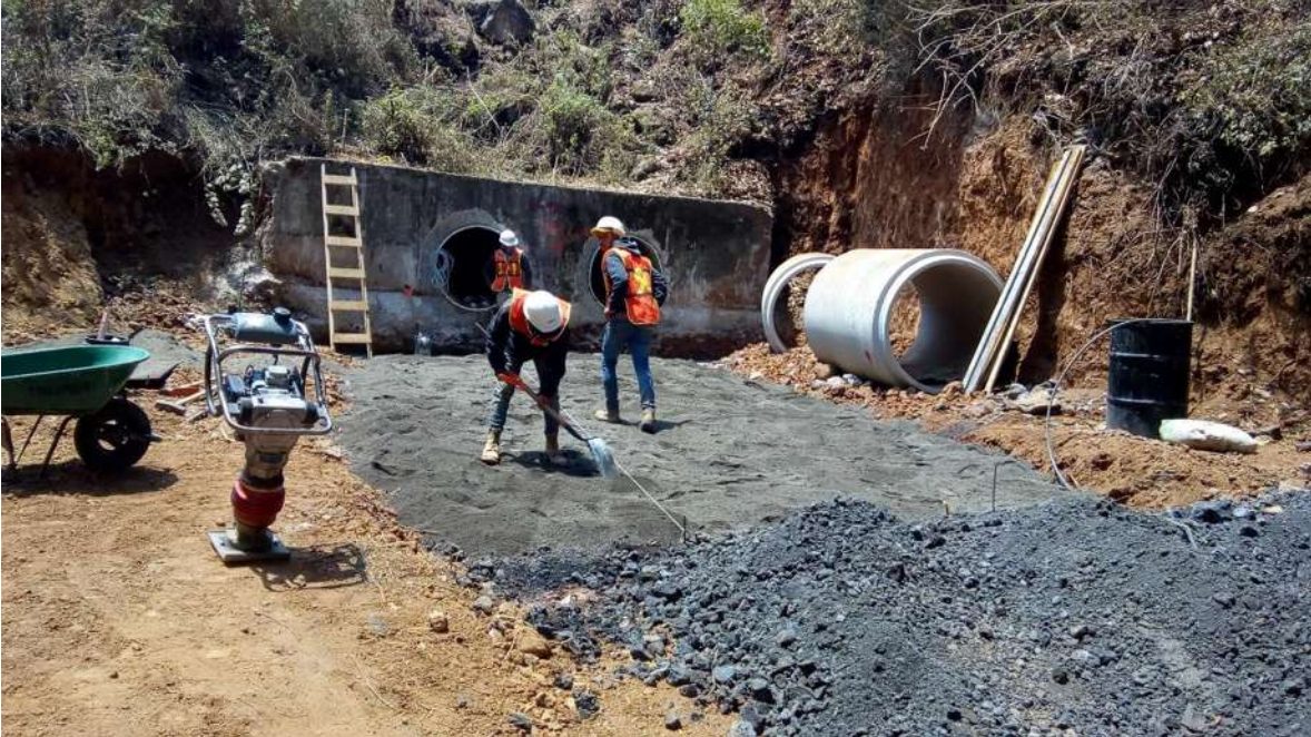
Figura 72. Suministro y colocación de cama de arena para sobre ella colocar los tubos de concreto.
