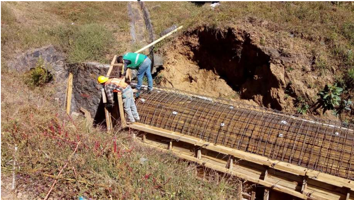
Figura 35. cimbrado de remates en bóveda.
