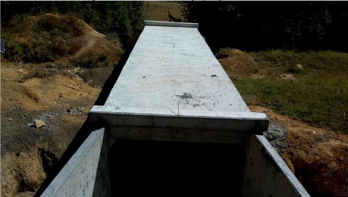
Figura 70. Vista frontal de la obra de drenaje terminada, en espera de los trabajos de terracerías.
