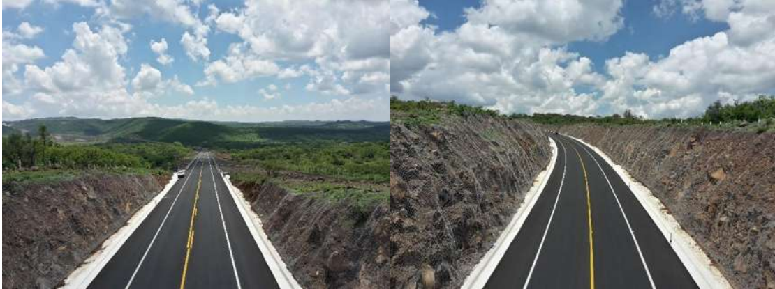
Figura 10. Se muestran las cunetas en ambos lados de la autopista como complemento a la definición anterior.
