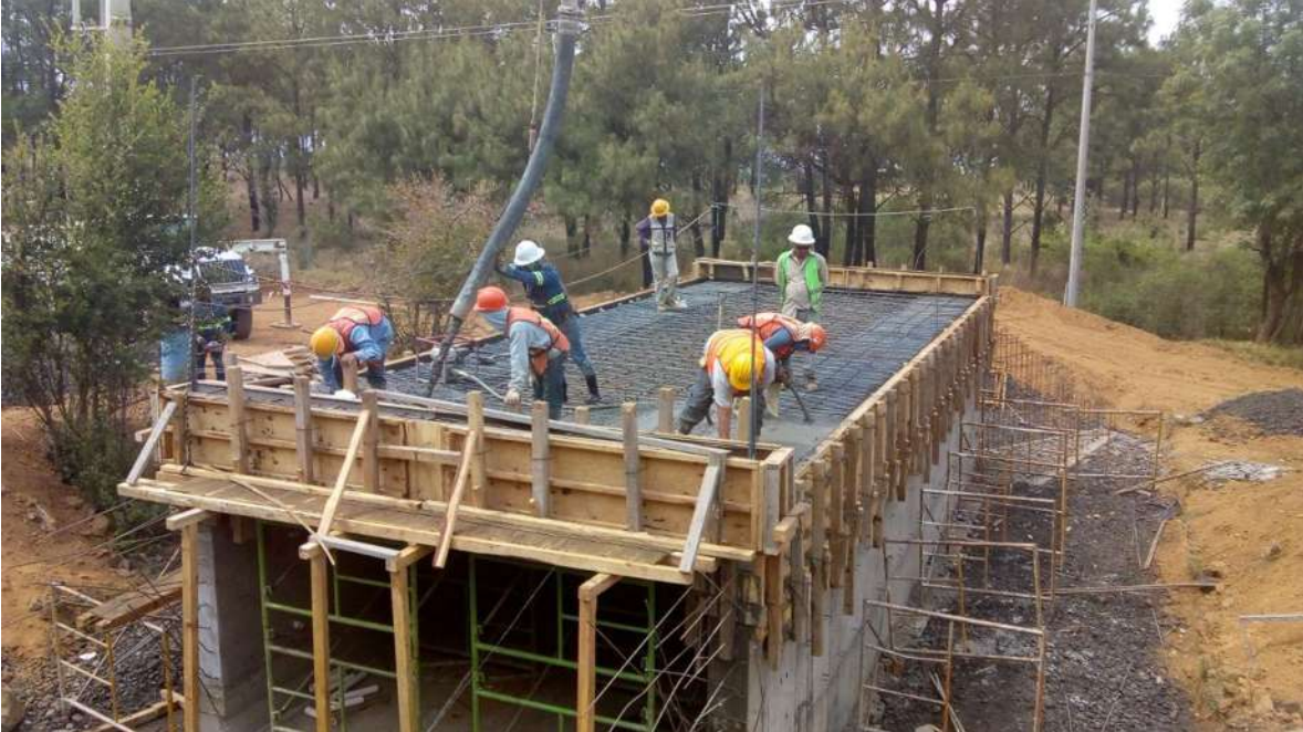
Figura 59. Cimbrado, habilitado y colado de losa superior.
