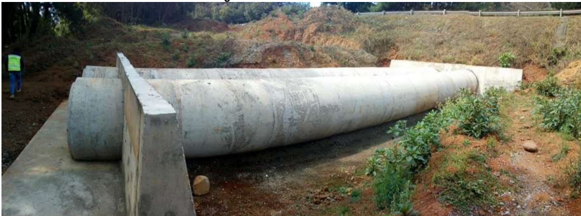
Figura 77. Descimbrado de cabezote en vista lateral.
