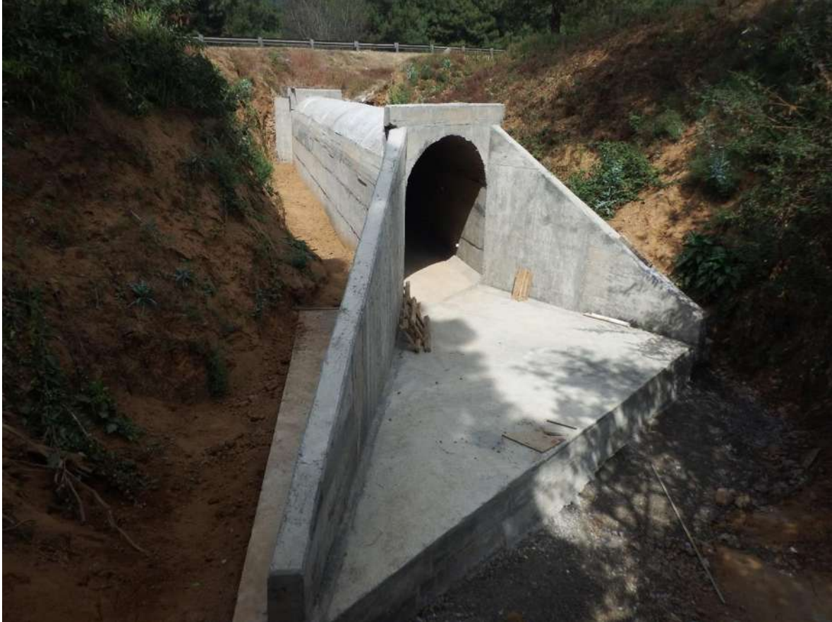
Figura 50. Vista aguas debajo de la bóveda de concreto terminada.
