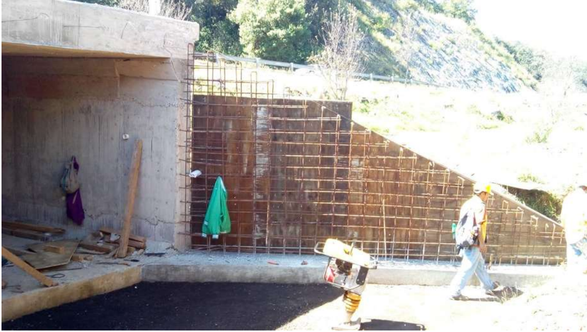
Figura 61. Habilitado de acero y cimbrado en aleros.
