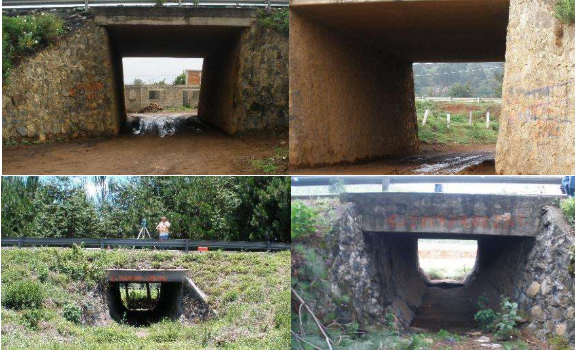
Figura 6. Se presentan losas de concreto hidráulico sobre cuerpo existente, como complemento a la definición anterior.
