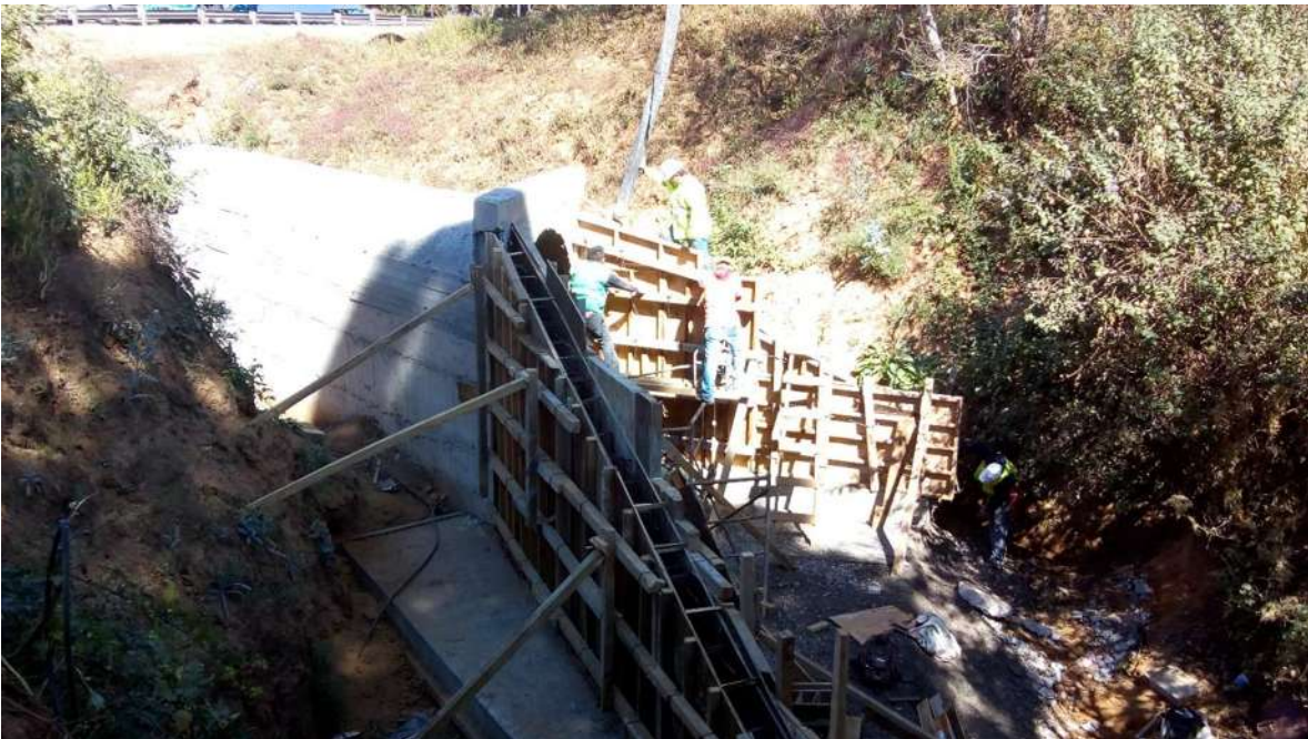
Figura 43. Colado de aleros aguas abajo.
