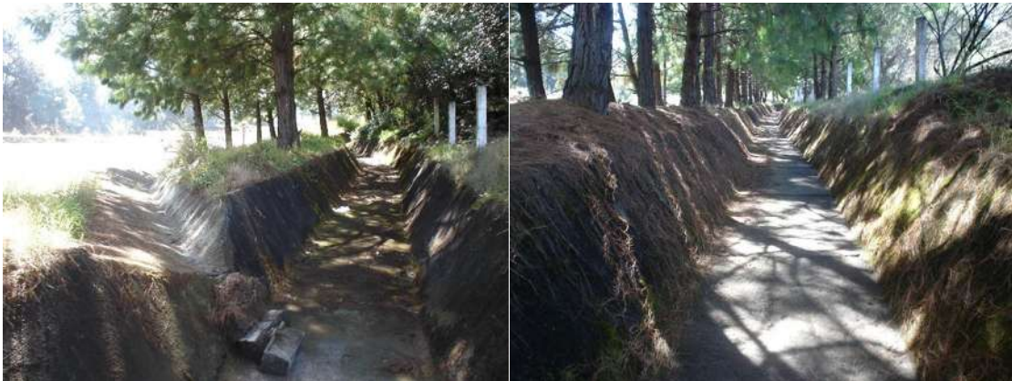
Figura 11. Se muestra un canal encauzamiento construido a un costado de la autopista, como complemento a la definición anterior.
