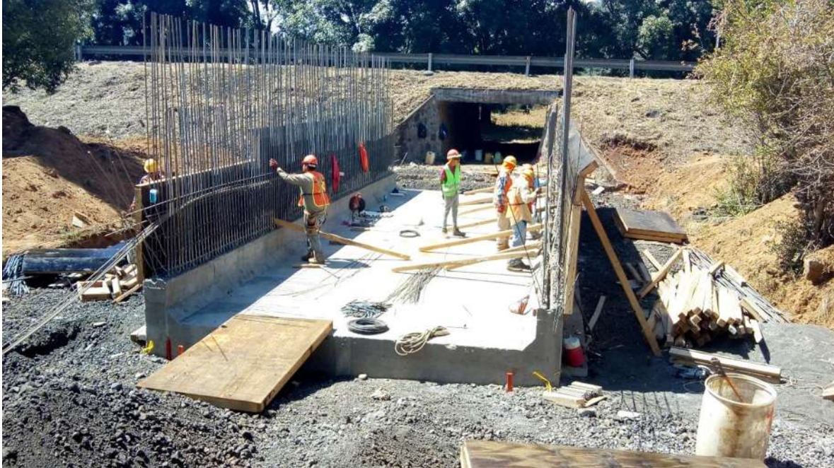
Figura 57. Habilitado de acero y cimbrado de muros laterales.
