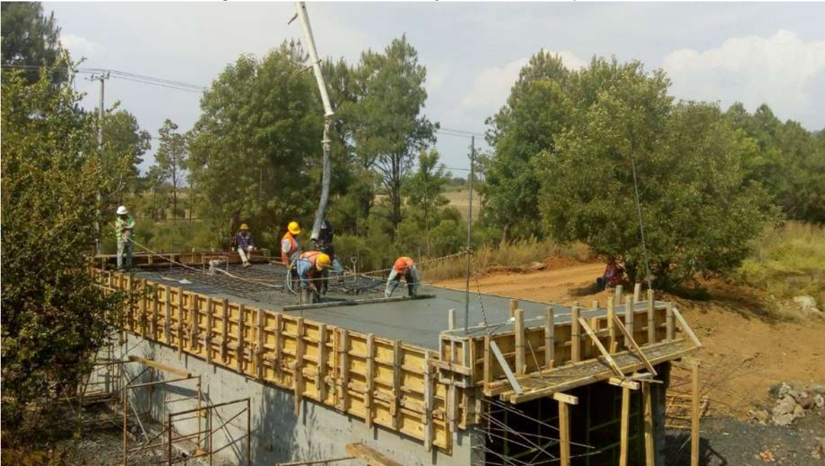
Figura 60. Colado de losa superior.
