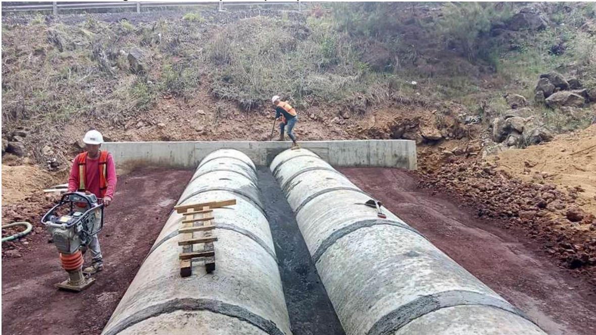
Figura 81. Inicio de aproches por capas con material calidad subrasante.
