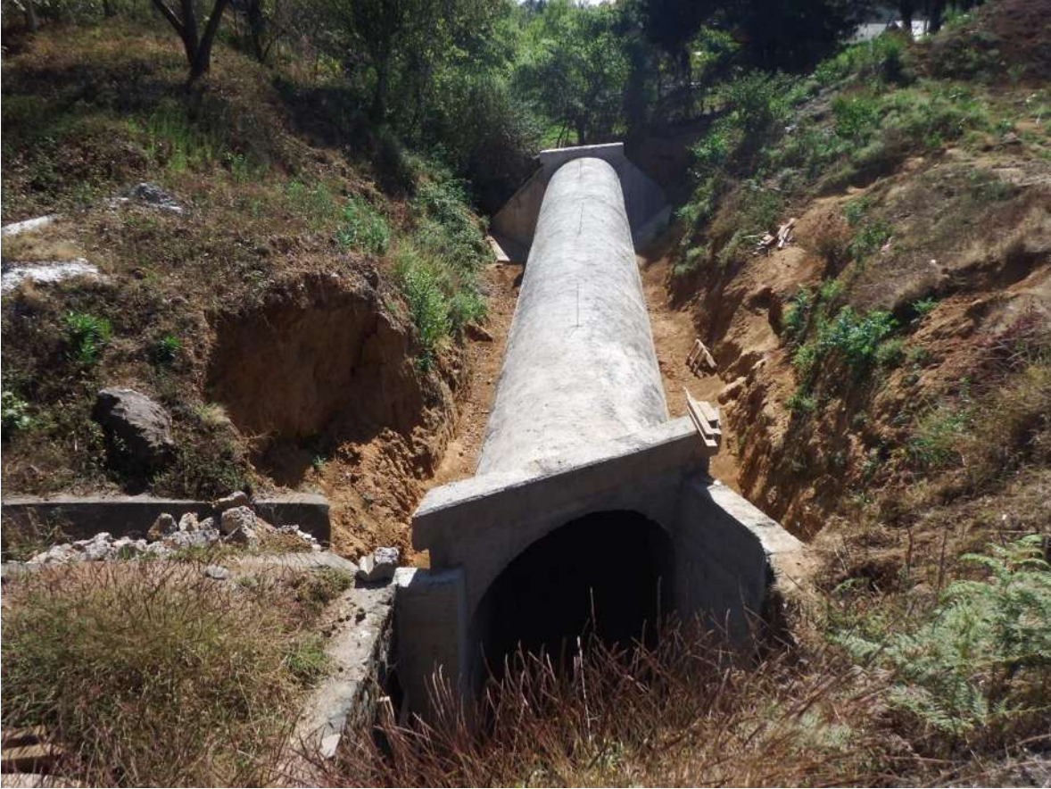
Figura 51. Vista frontal aguas arriba de la bóveda de concreto terminada.
