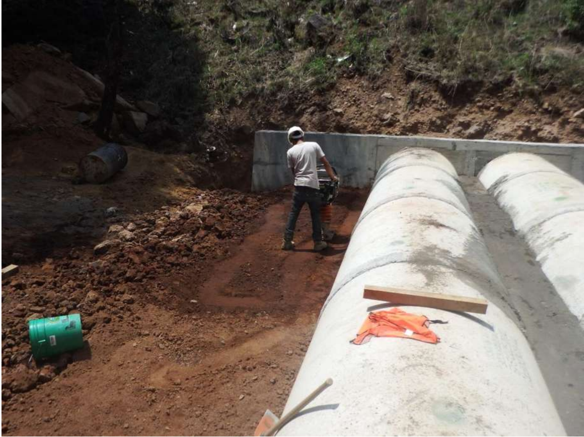
Figura 81. Inicio de aproches por capas con material calidad subrasante.
