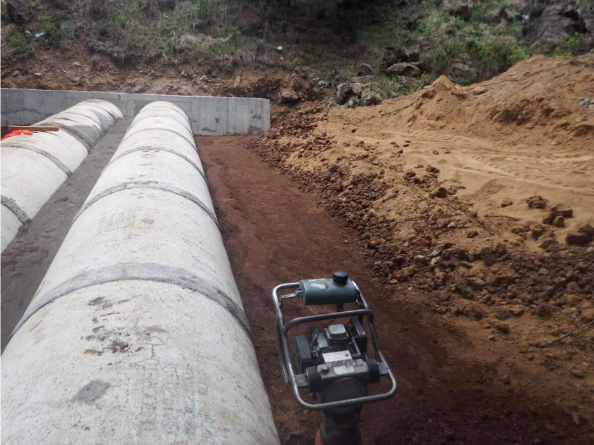
Figura 80. Inicio de aproches por capas con material calidad subrasante.
