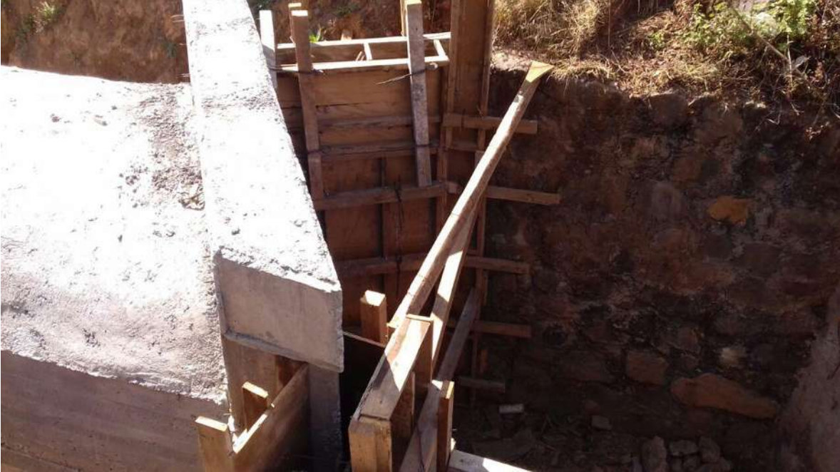
Figura 46. Cimbrado de aleros nuevos con liga a los aleros existentes.
