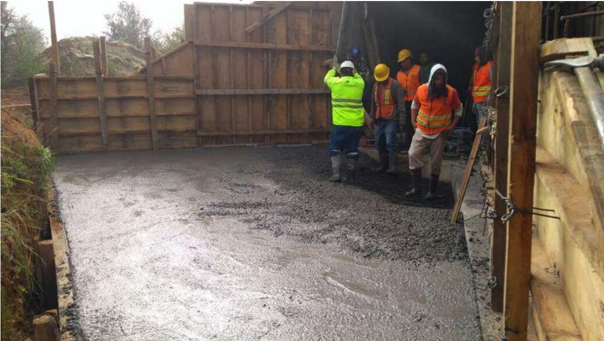
Figura 64. Colado de zampeado de concreto.
