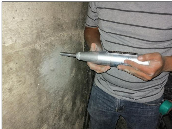
Figura 1. 72 Realizando prueba de Esclerometría en campo. (Granados Ceras, 2020).
