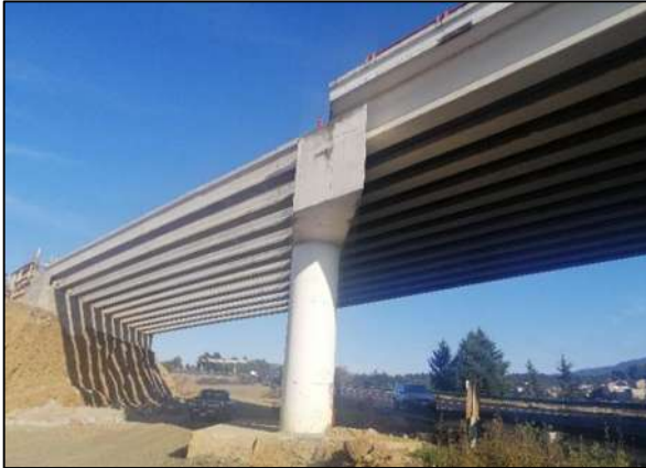
Figura 1.14 Ampliación Puente Vista Bella, carretera siglo XXI, km 54. (Granados Ceras).
