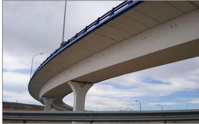
Figura 1.23 Puente curvo. (Comunicación, 2017).
