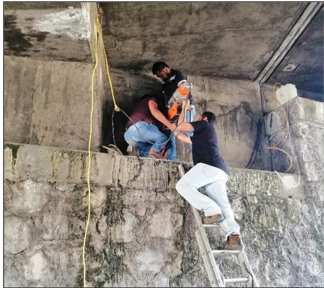
Figura 1. 76 Extracción de corazones. (Granados Ceras, 2020).
