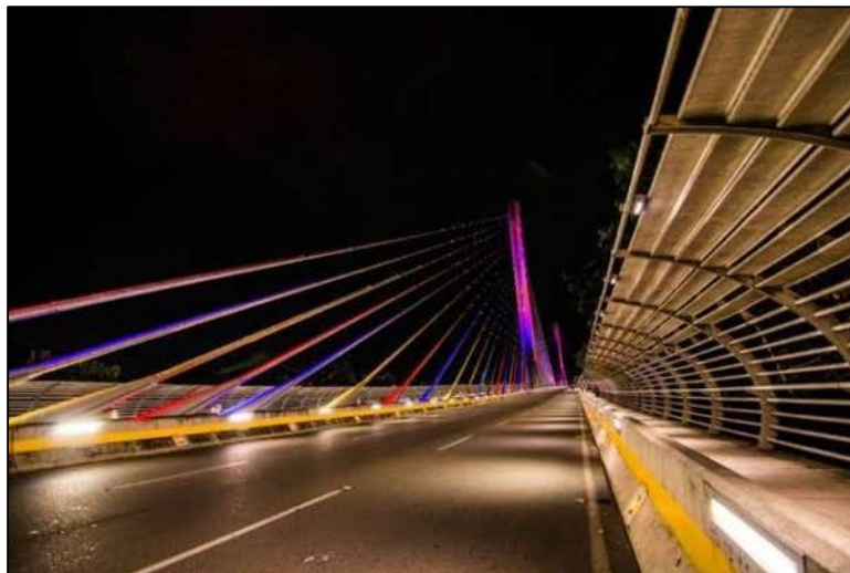
Figura 1.13 Puente Viaducto Provincial, Bucaramanga, Colombia. Puente mixto. (Rodríguez, 2018).
