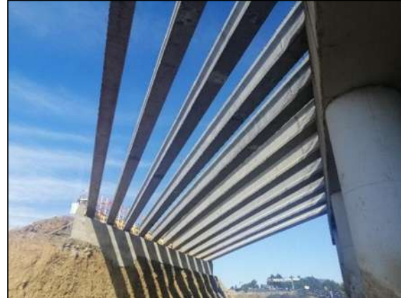
Figura 1.15 Vigas del puente Vista Bella, carretera siglo XXI, km 54. (Granados Ceras).
