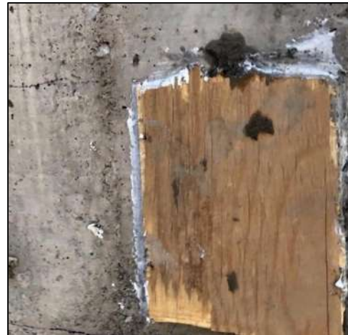
figura 82. Cimbrado de perforación producto de extracción.
