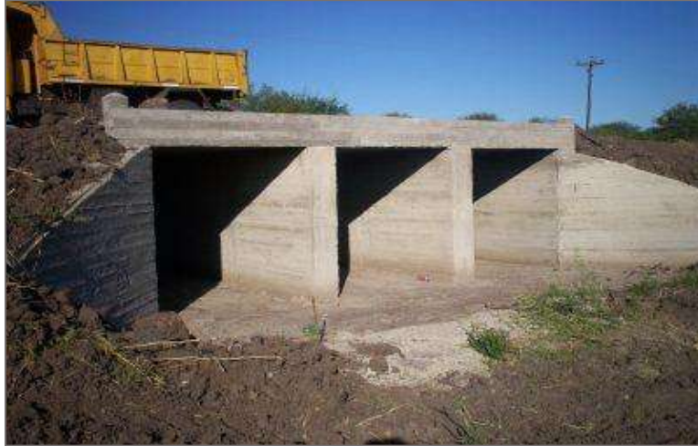
Figura 1.8 Puente alcantarilla, (Dpvfederal, 2010).
