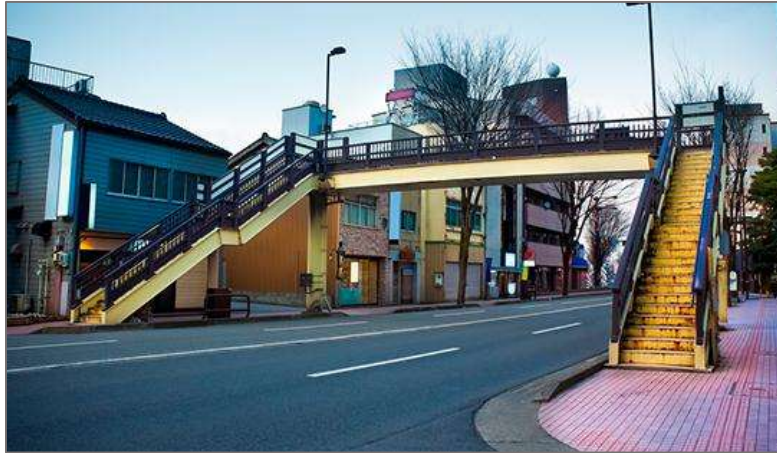
Figura 1.12 Puente Peatonal, (Vana, s.f.).
