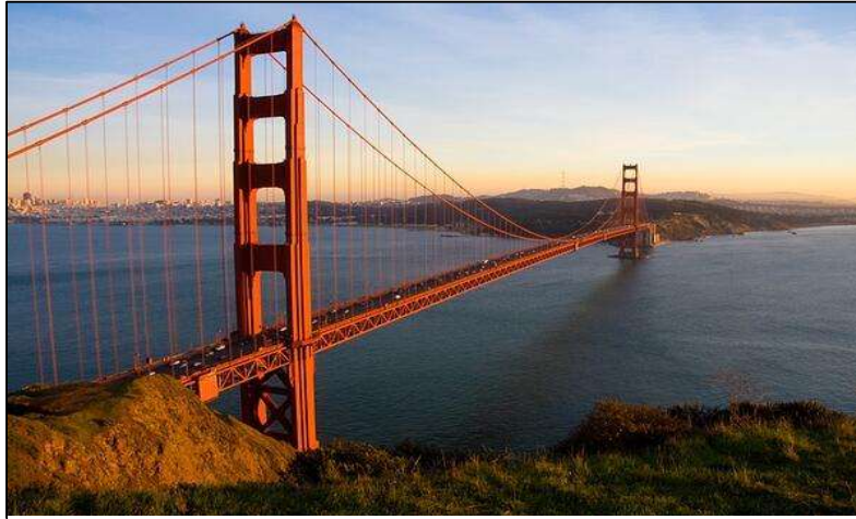
Figura 1. 21 Puente Colgante Golden Gate, San Francisco, California. (Structuralia, 2017).
