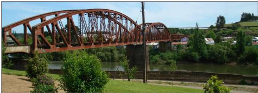
Figura 1. 10 Puente ferroviario sobre el río Cholchol, Francia. (Sur, 2014).
