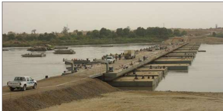
Figura 1.24 Puente temporal, (Comunicación, 2017).
