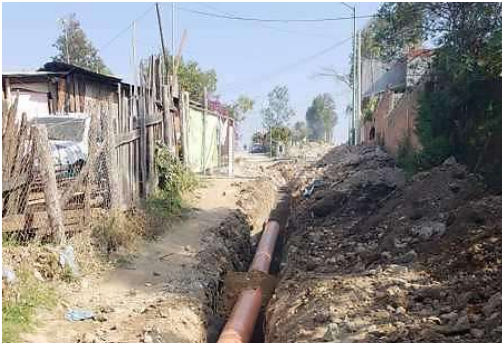
Ilustración 6. Construcción de una red de alcantarillado sanitario.
