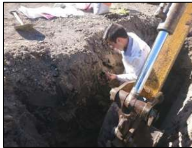
Figura 15. Verificando la consistencia del suelo.
