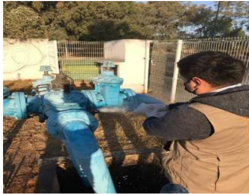
Válvula del sistema y captación del agua en los recipientes de medición de los pozos de agua subterránea.
