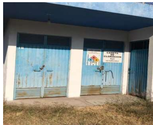
Caseta de cloración
