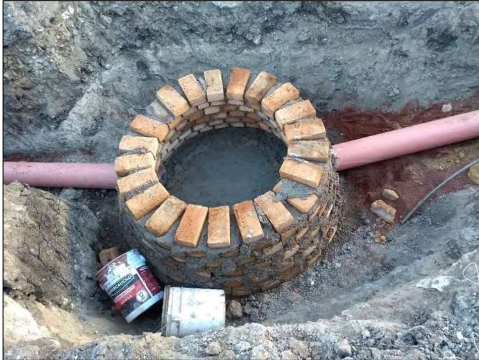
FIGURA 6.4 POZO DE VISITA COMÚN.
