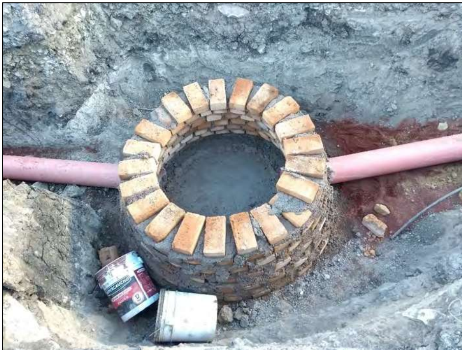
FIGURA 5.4 POZO DE VISITA HECHO EN OBRA.
