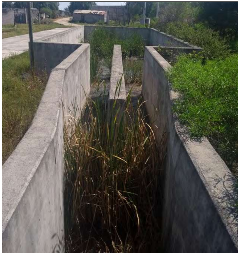
FIGURA 4.7 PLANTA DE TRATAMIENTO.
