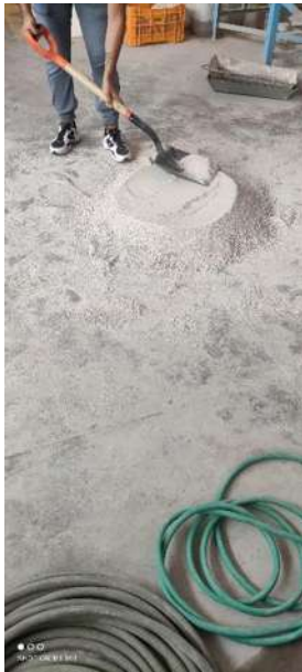
Ilustración 14. Aplanado de la parte superior del cono formado con el material. Fuente: Propia
