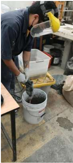
Ilustración 59. Mezclado mecánico del mortero. Fuente: Propia
