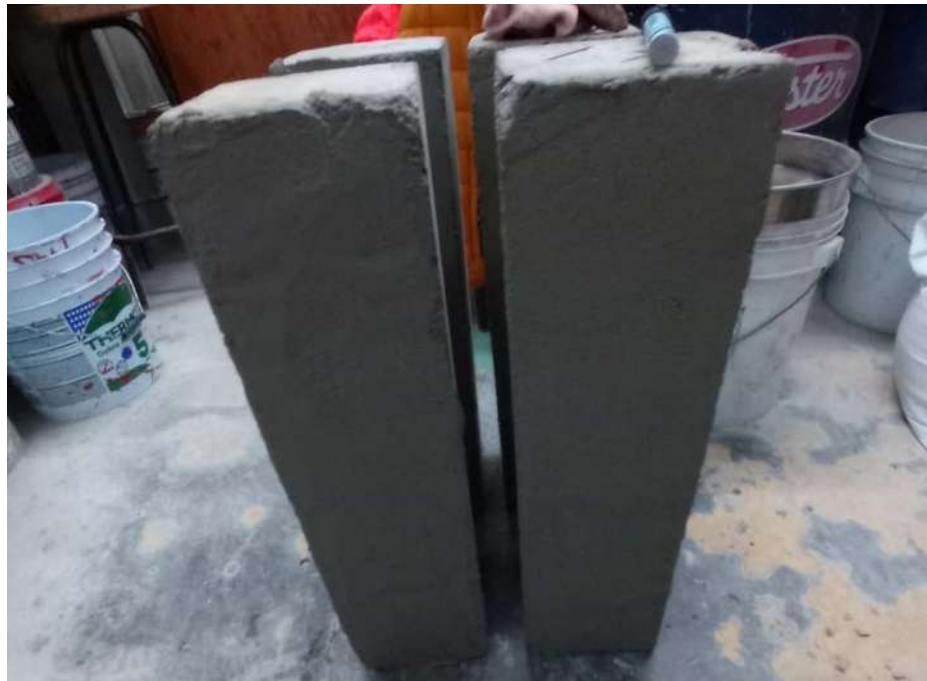
Figura 41. Repello en vigas de concreto con cuchara de albañilería. (C. A. Díaz Ávila)
