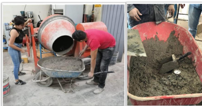
Figura 3.3. Vaciado de mezcla en carretiva y toma de lectura de temperatura. Fuente:Elaboración propia.
