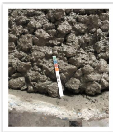
Figura 4.39 Colocación de tira indicadora sobre la muestra de concreto fresco. Fuente: Elaboración propia.
