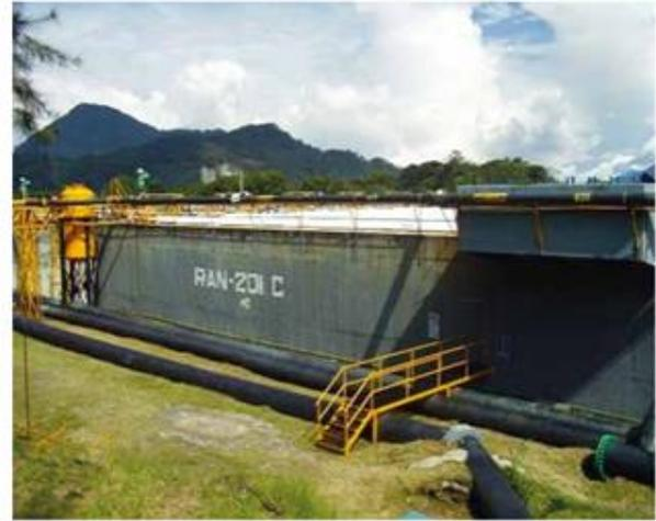
Reactor Anaerobio de Flujo Ascendente
