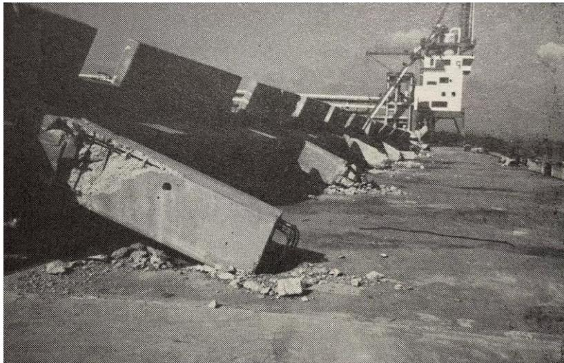
**Figura 149** Se muestra la estructura del transportador volcada en toda la ruta a lo largo del muelle la grúa pórtico del fondo sufrió daños menores.
