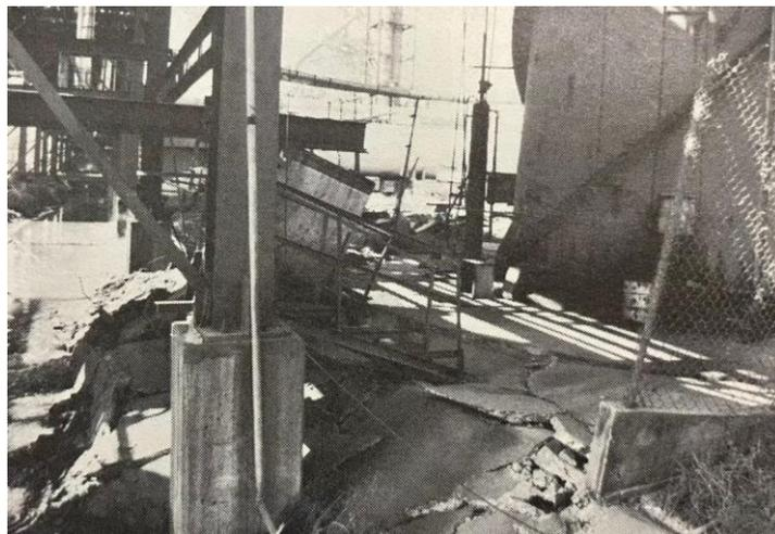
**Figura 136** La base de concreto de la chimenea (figura 135) se inclinó y se levantó
