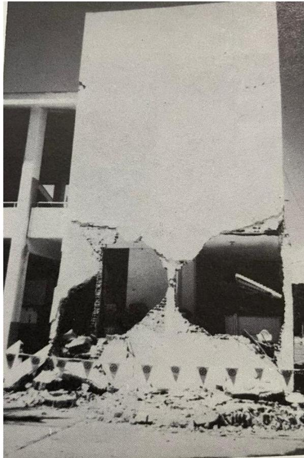
**Figura 111** La pared del extremo colapsada del edificio de oficinas mostrado en la figura 86
