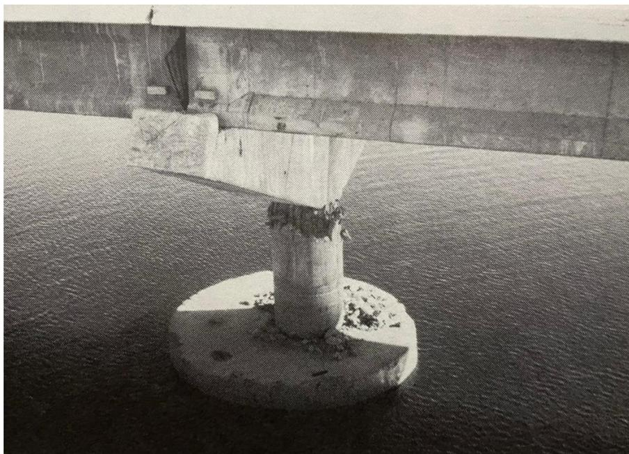
**Figura 118** Muestra el daño a un pilar, donde las varillas del acero de refuerzo quedaron expuestas en el concreto dañado.
