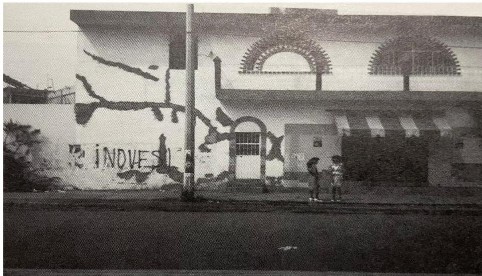
**Figura 115** Ejemplos de reparación de grietas de cortante en edificaciones, tal como la mostrada, fueron evidentes por todas partes en la ciudad después de un año del sismo (Juguería Acapulco)
