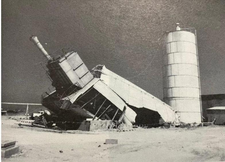
**Figura 119** Un silo de almacenamiento de cemento en la planta de distribución COPSA volcado empujando la torre de carga de camiones adyacente a ella
