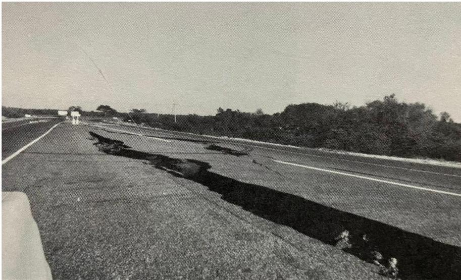
**Figura 122** Aparecieron grandes fisuras en el pavimento de asfalto de esta carretera cerca de Lázaro Cárdenas. (complemento)
