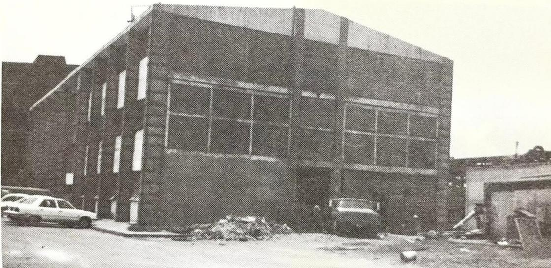
**Figura 131** Se muestra el trabajo de reparación en curso en un edificio de cuatro pisos, edificio de oficinas con estructura de concreto reforzado que sufrió colapso en muros interiores de mampostería
