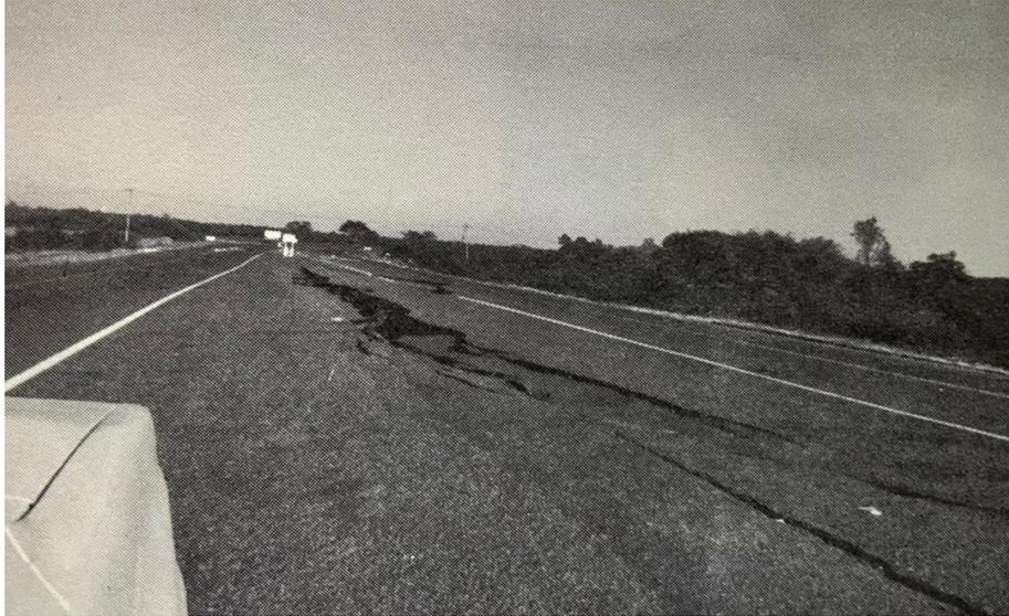
**Figura 121** Aparecieron grandes fisuras en el pavimento de asfalto de esta carretera cerca de Lázaro Cárdenas.
