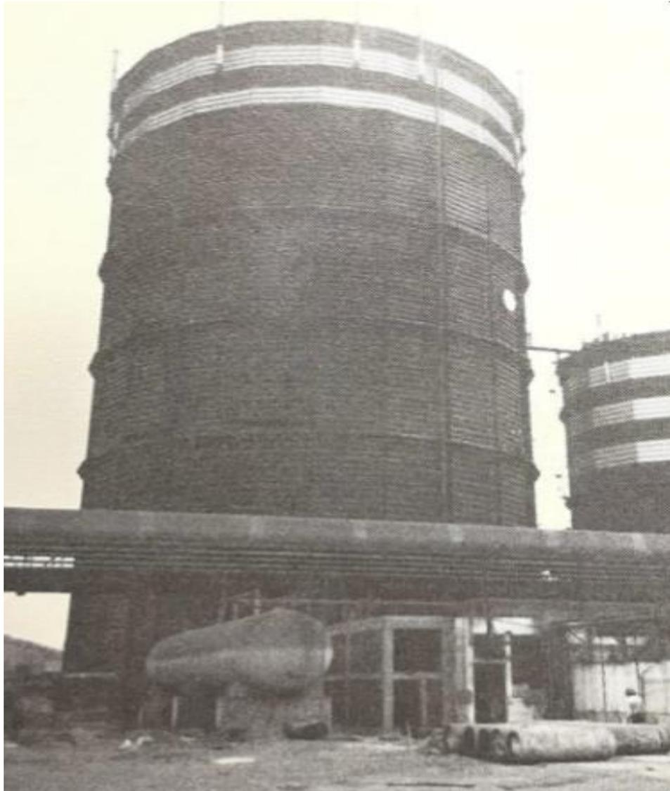
**Figura 133** Una de las pérdidas más graves en el sitio de la empresa SICARTSA fue el daño al tanque de almacenamiento de combustible de gas, un cilindro de 30 metros de diametro por 90 metros de alto construido de placas de acero remachadas a un marco exterior de acero estructural. Fugas en el tanque impidió su uso como plenum de combustible de gas durante muchos meses después del terremoto.
