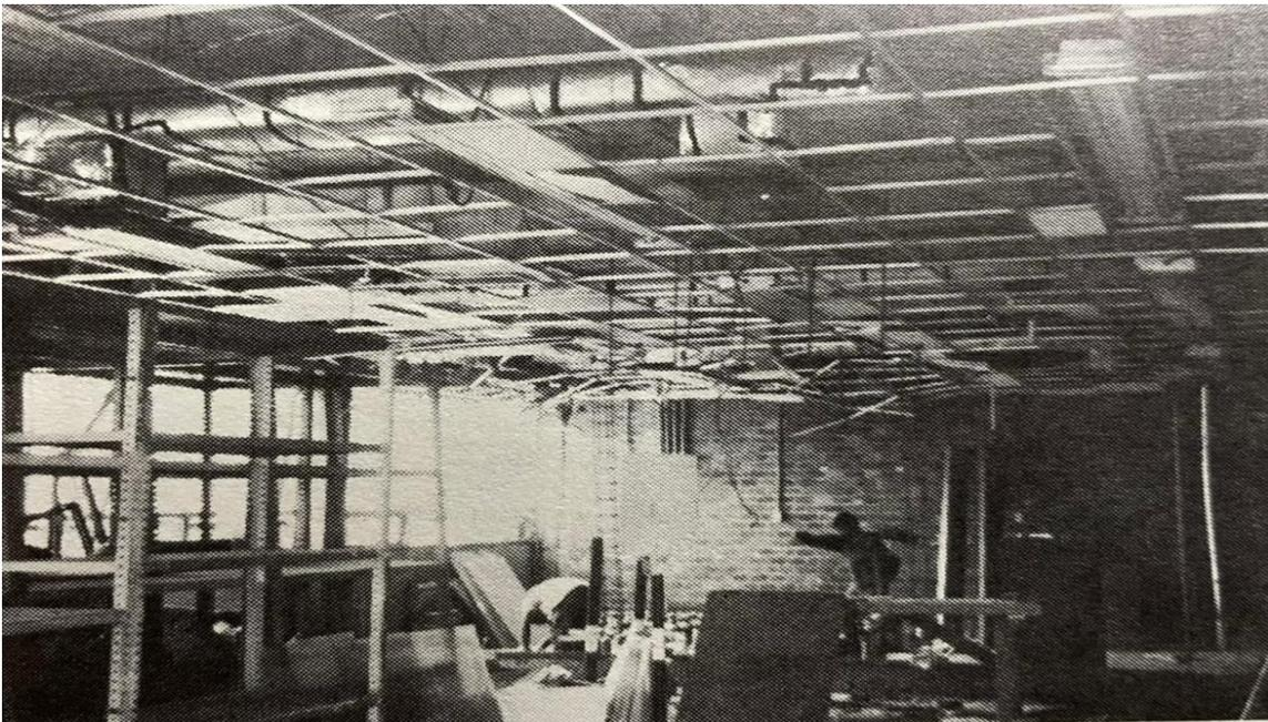
**Figura 132** El edificio de la figura anterior (Figura 101), que sufrió colapso en accesorios internos tales como cielo raso suspendido.
