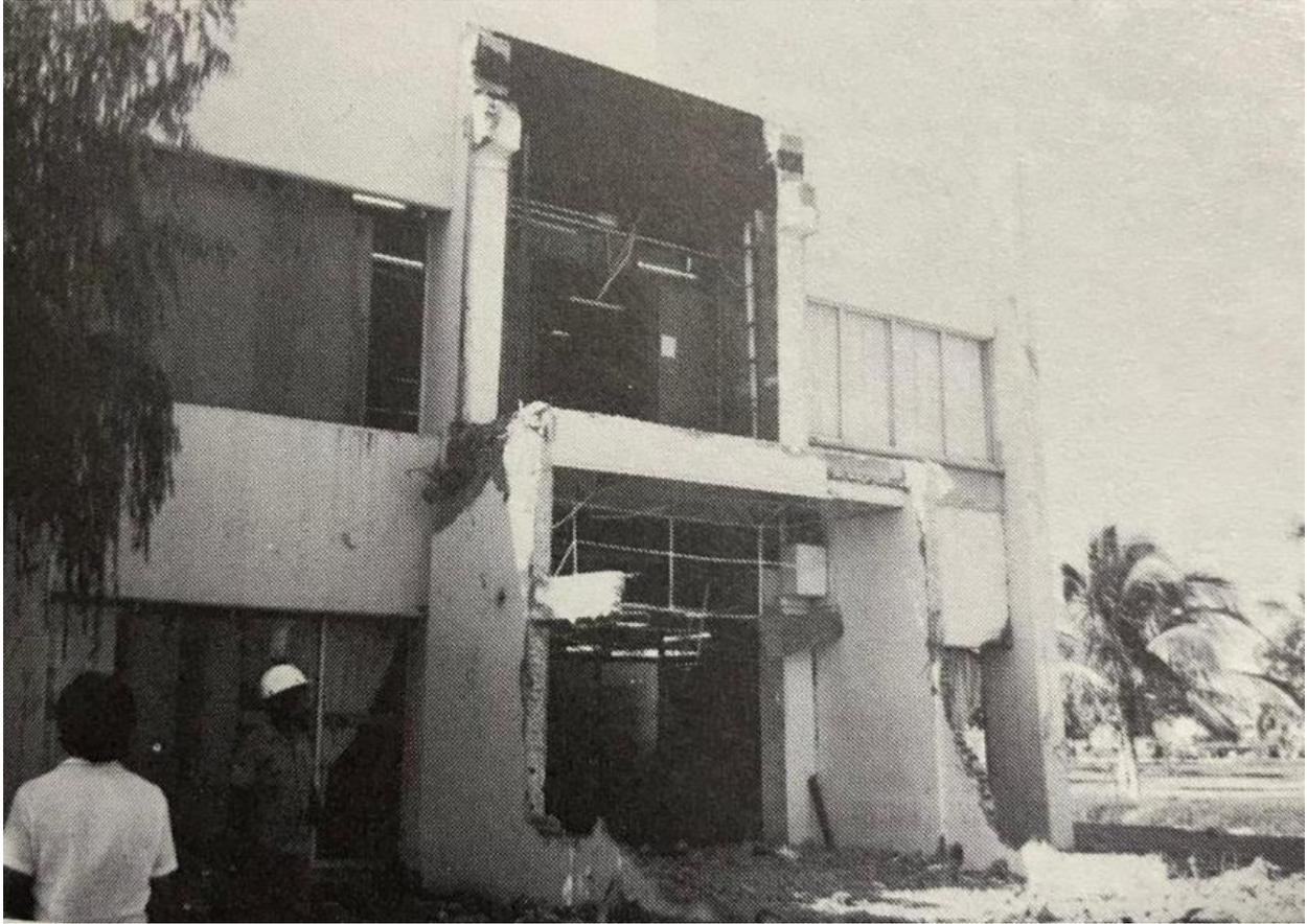
**Figura 129** Uno de los edificios más dañados en la empresa SICARTSA fue el edificio de administración con estructura de concreto reforzado de dos plantas, que sufrió graves daños en la estructura y en los muros de mampostería.
