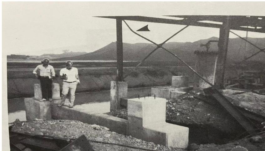
**Figura 138** El pedestal de cimentación típico que fue sustituido, observe las diagonales de los contravientos dañadas en el marco.
