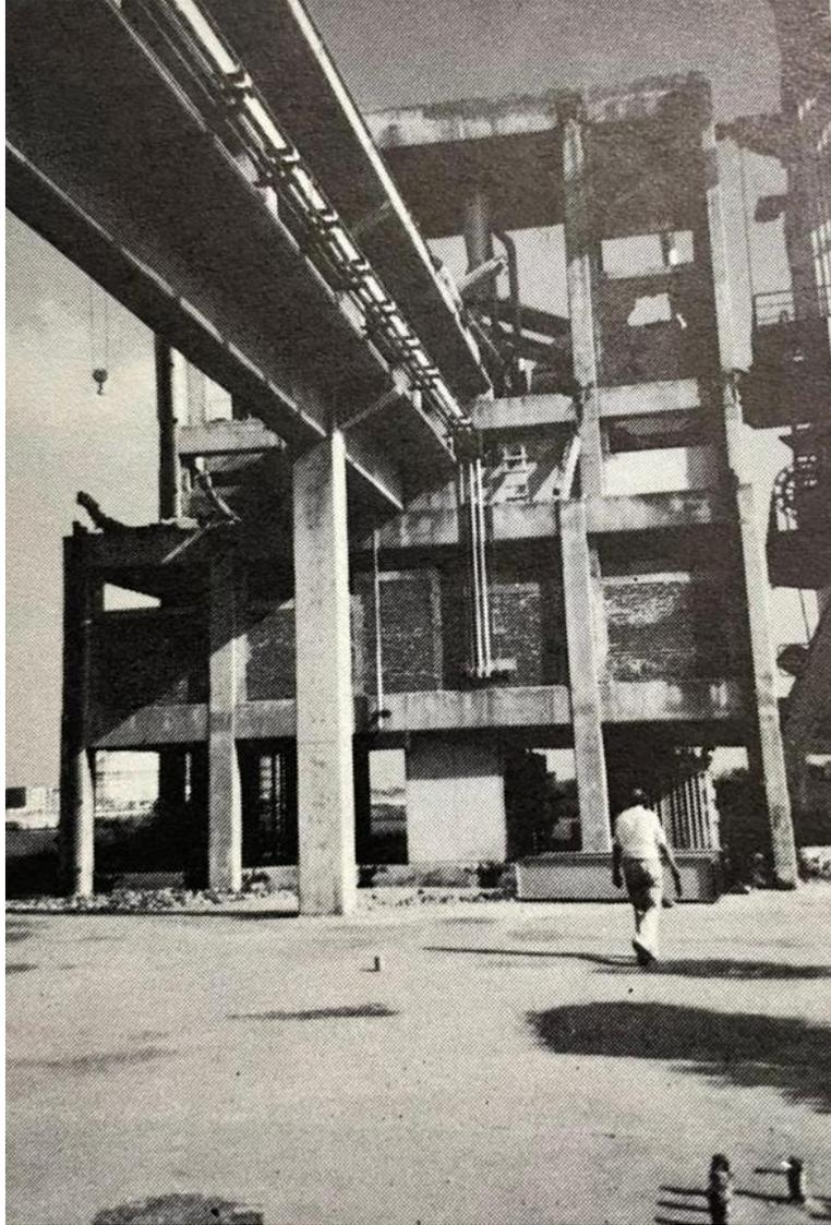
**Figura 150** La estructura de accionamiento del transportador es un marco de concreto con relleno de mampostería.
