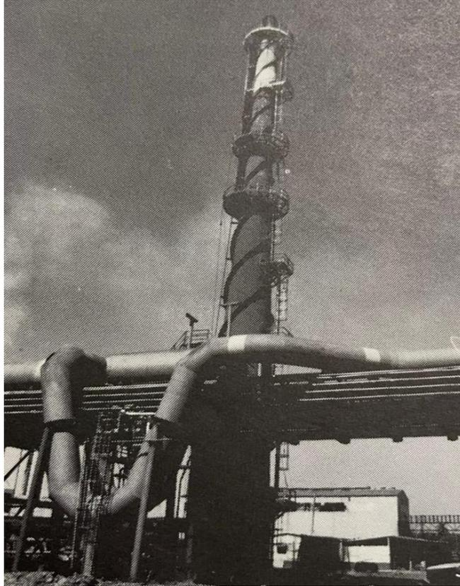
**Figura 135** La chimenea de acero se inclinó debido al asentamiento del suelo..
