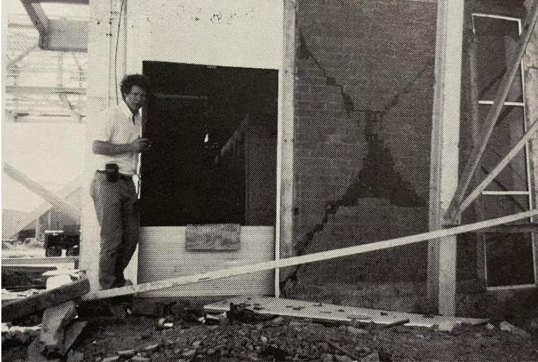
**Figura 144** . El edificio sufrió daños sustanciales en los muros de mampostería y el marco de concreto, aquí se muestra el detalle de la figura anterior.
