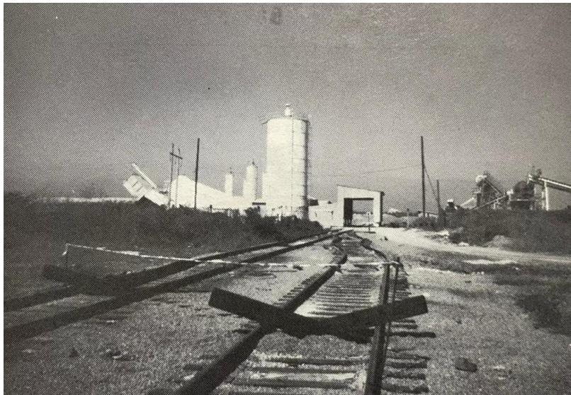
**Figura 120** El ferrocarril con las pistas cercanas a la planta de cemento estaban distorsionadas por fallas en el suelo
