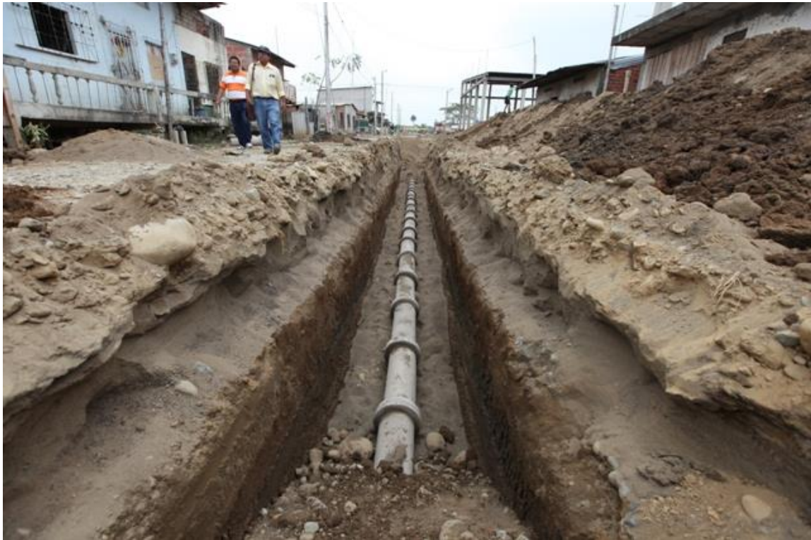
Imagen 5.1 Construcción de Sistema de Red de Alcantarillado
