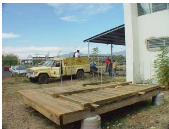
Figura 5. Colocación de muros, (FITECMA, 2003)
