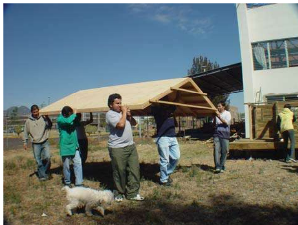
Figura 11. Cubierta de techo con triplay, (FITECMA, 2003)
