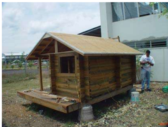
Figura 17. Cubierta de Techo, (FITECMA, 2003).
