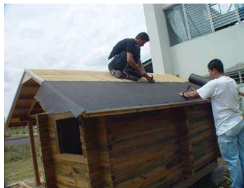
Figura 18. Colocación de impermeabilizante, (FITECMA, 2003)
