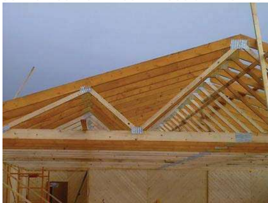
Figura 16. Ejemplo de armadura de Techo, (hardwoodquality.s/f)
