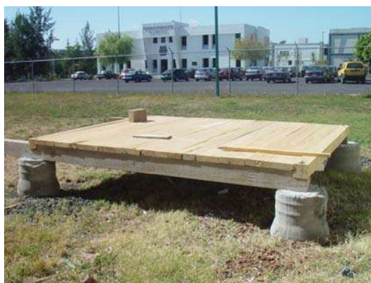
Figura 4. Tablones de piso, (FITECMA, 2003)
