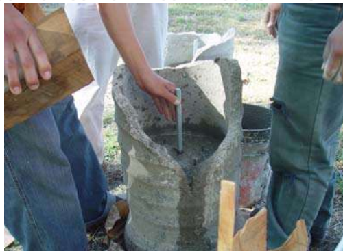
Figura 3. Colado de una zapata, (FITECMA, 2003)
