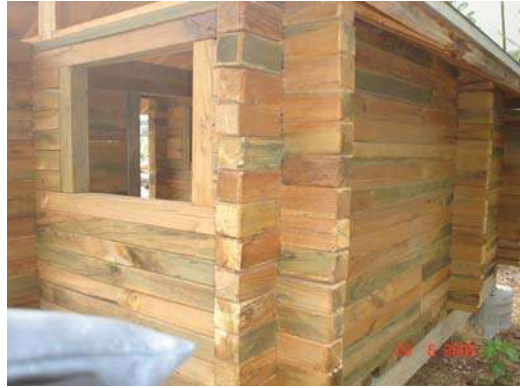
Figura 13. Detalle de esquinas, (FITECMA, 2003).
