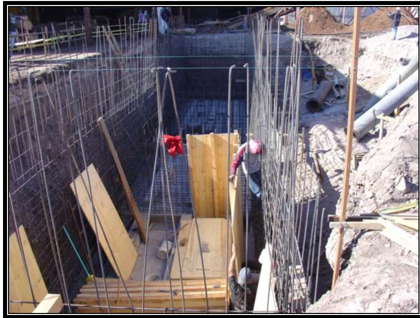
Figura 7. Pisos terminados y levantamiento de muros
