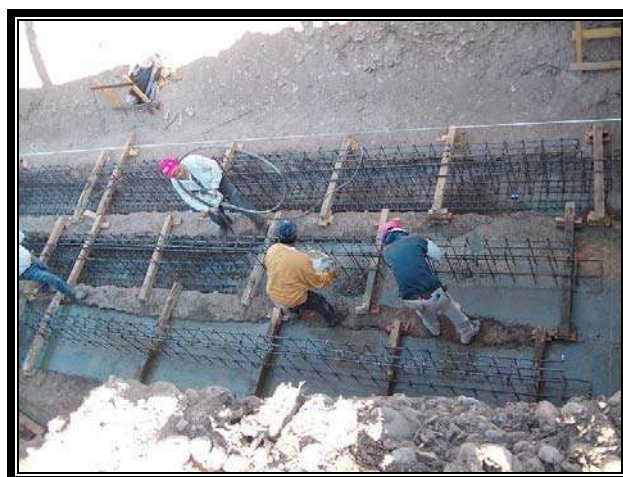
Figura 4. Desplante de la cimentación.
