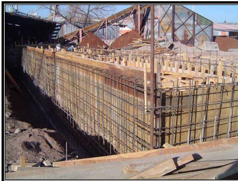
Figura 8. Emparrillado de los muros.
