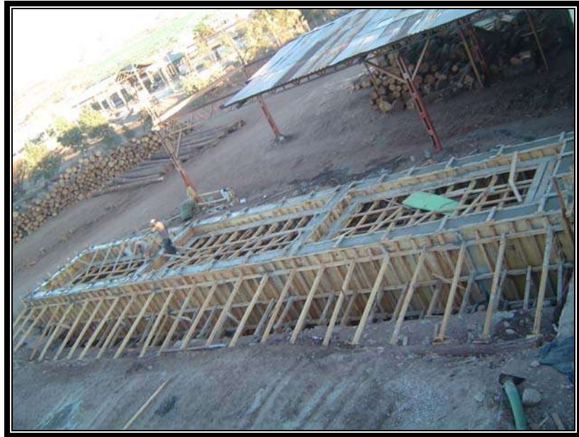
Figura 9. Vista de la obra civil concluida
