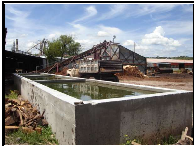
Figura 10. Pilas de calentamiento con agua para la detección de filtraciones.
