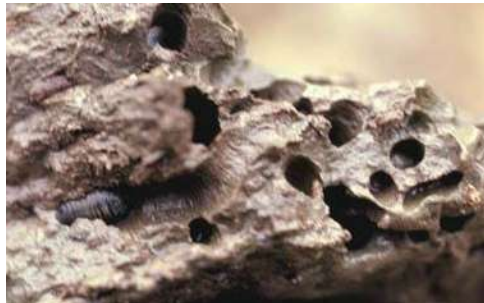
Figura 104. Daños por Sphaeroma Fuente: (FAO, 2008)
