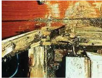
Figura 71 Daños por Reticulitermes hesperus Banks Fuente: (Mora, 2006)
