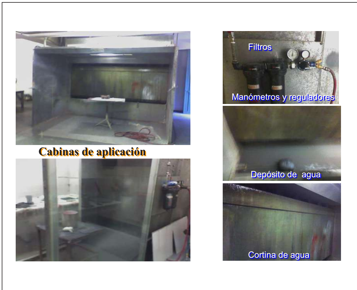
Figura 21. Cabina de aplicación de cortina de agua.
