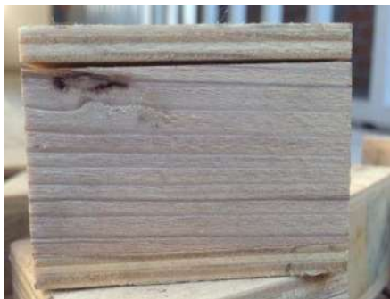
Figura 20. Delaminación vista a lo largo del tablero.
