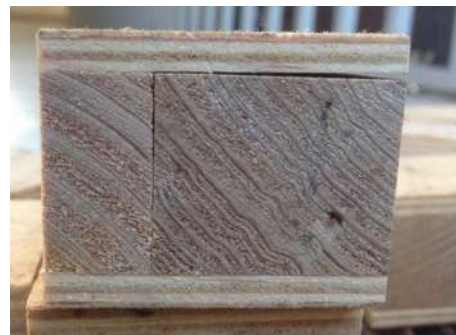
Figura 21. Delaminación vista en el sentido transversal del tablero.
