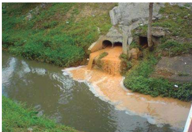
Figura 1.1. Descarga de agua residual de la planta potabilizadora
