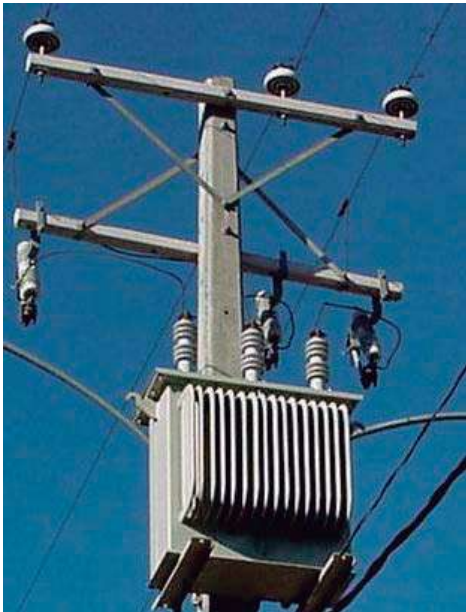
Figura 15: Transformador de distribución
