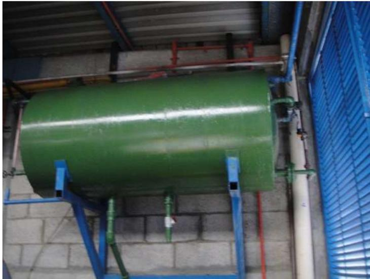
Fig. 3.11. Tanque de alimentación de agua a la caldera.
