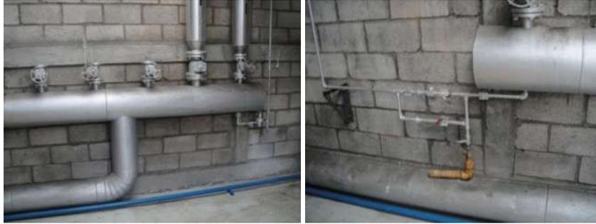
Fig. 3.9. Cabezal de distribución de vapor.
