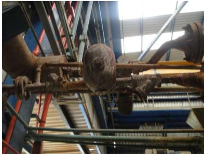
Fig. 3.16. Trampeo sobredimensionado y fugando vapor.
