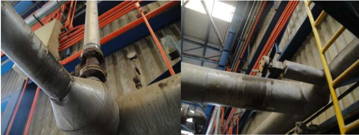
Fig. 3.13. Líneas de distribución sobredimensionadas y sin eliminación de condensado y aire.
