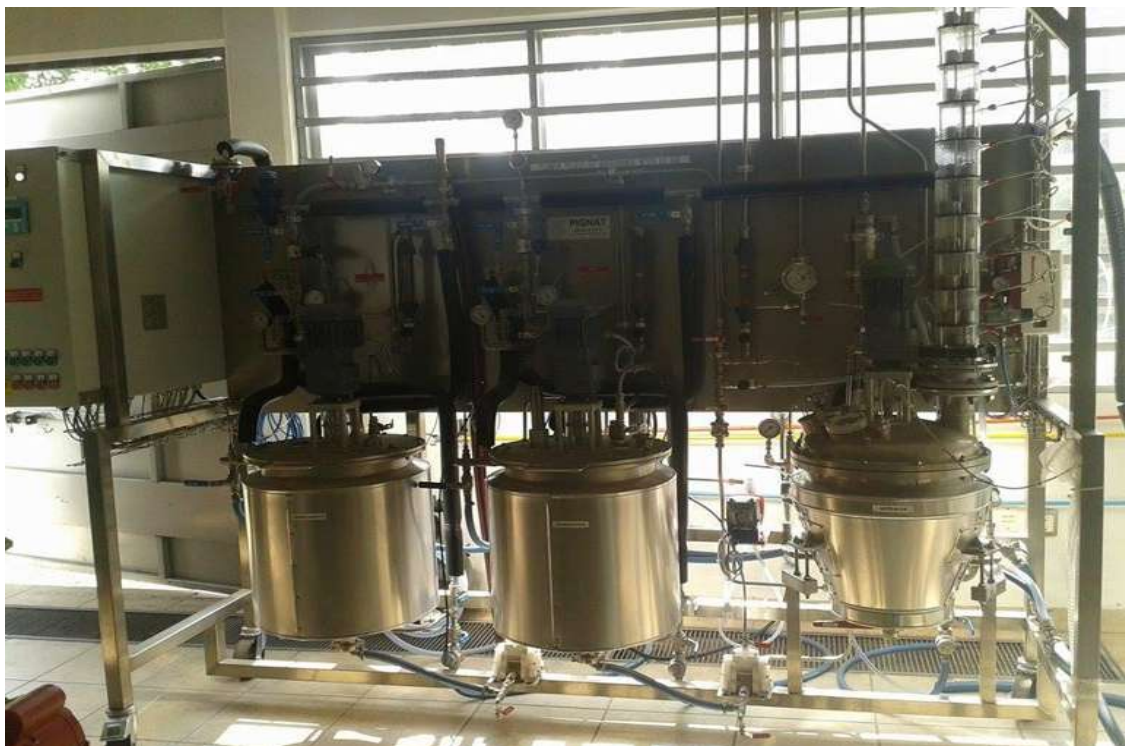
Fig. 18: Imagen de la planta piloto
