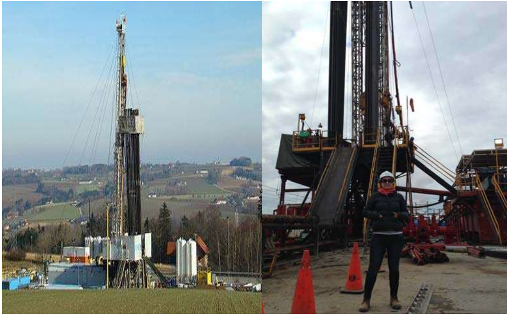
Figura 18.- Equipo de perforación convencional.
