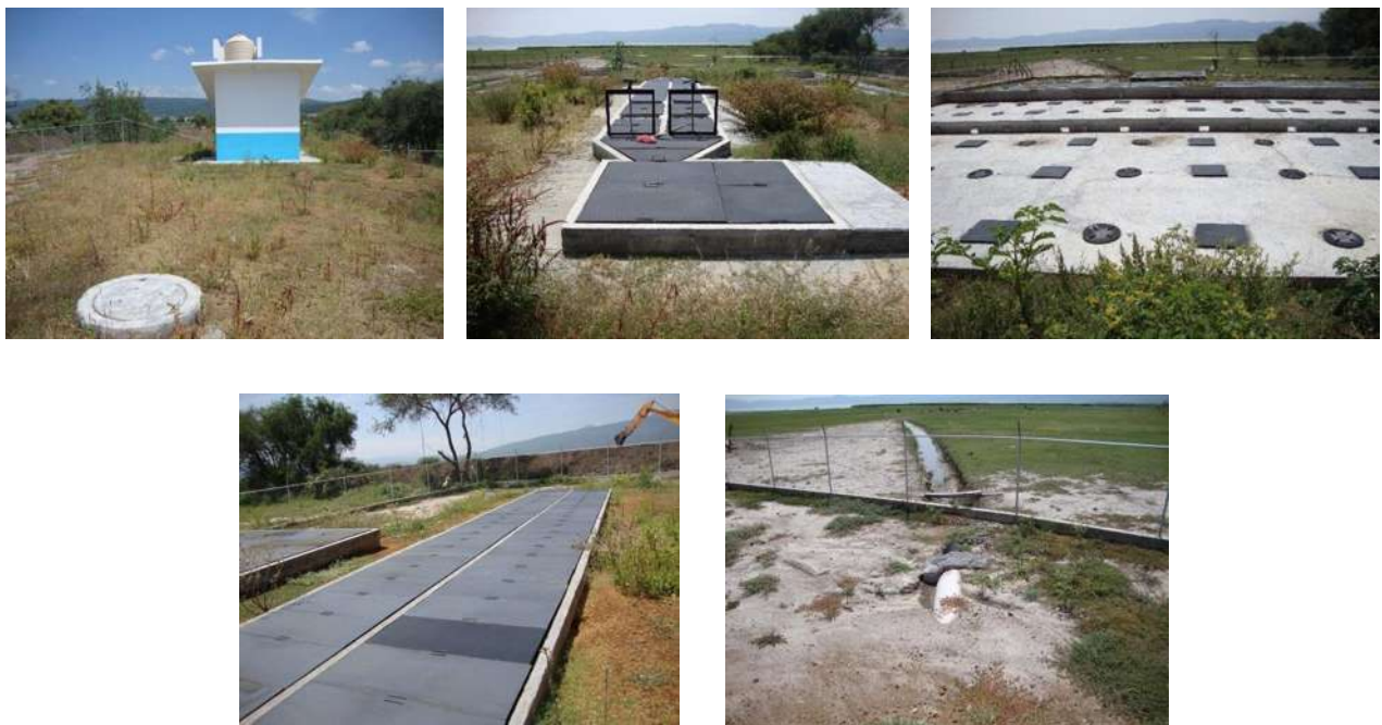
Figura 20.- PTAR de Huandacareo.
