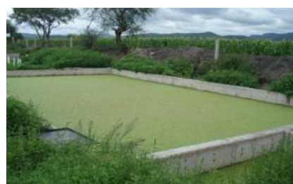
Estructura para filtro de material graduado
