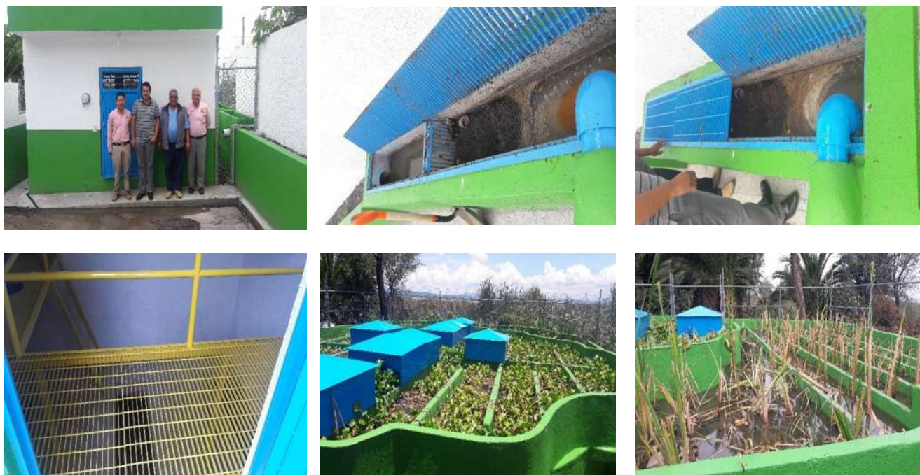
Figura 48.- Sistema después de las modificaciones PTAR Chehuayo.
