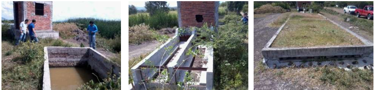
Figura 8.- PTAR de Cuaracurio.
