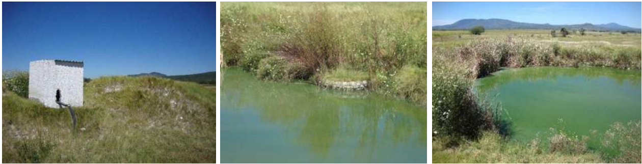
Figura 26.-Laguna de oxidación.
