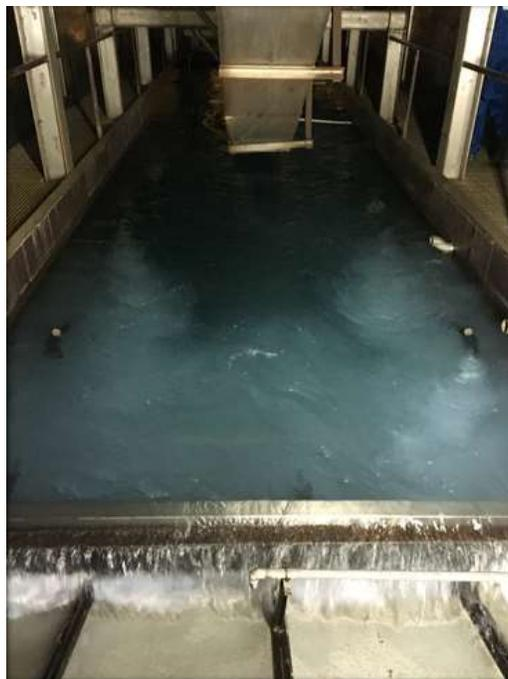
Figura 3.10. Carga del tanque de proceso con agua limpia de pozo.
