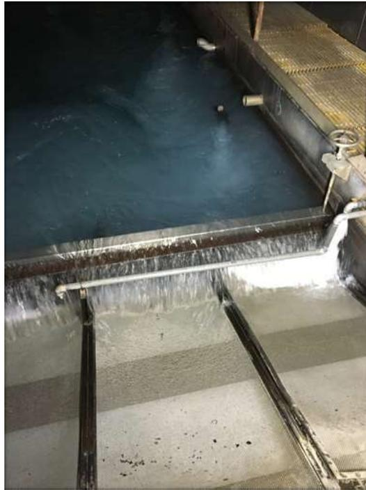
Figura 3.12. comienzo de la carga del acondicionador versabond en el carcamo de succión.
