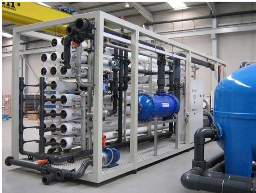
Figura 1.18. Osmosis inversa de un proceso industrial.
