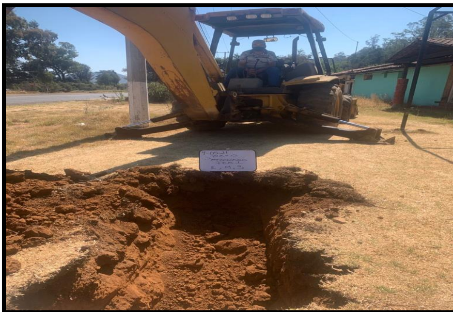
FOTO. VISTA DE LA CALLE: LOCALIDAD DE PÁTZCUARO, MICHOACAN
