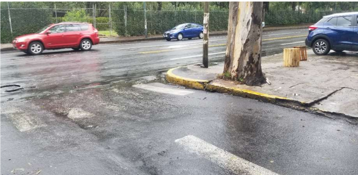
Fotografía 6. Desnivel ubicado en Avenida Ventura Puente, donde tras el paso de lluvias intermitentes se suele inundar.
