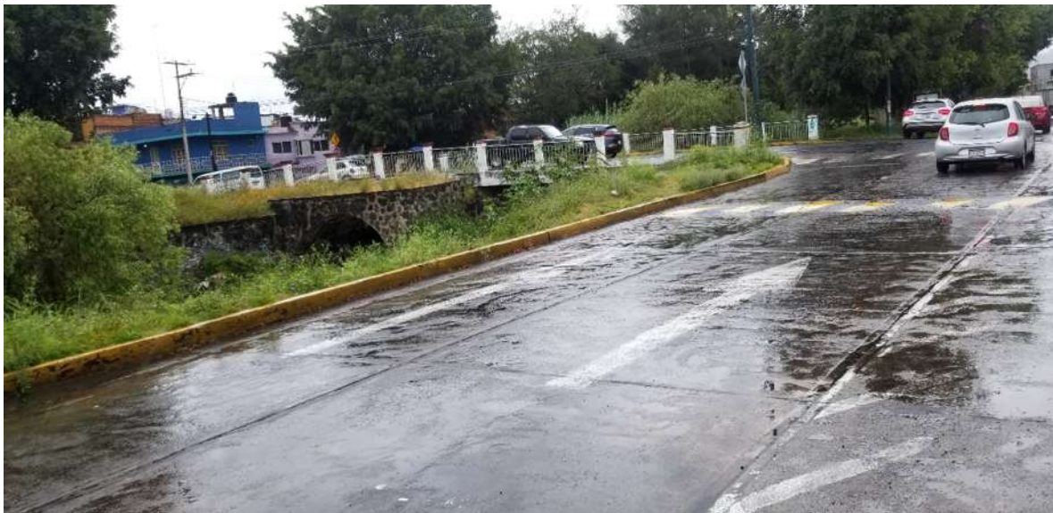
Fotografía 2. Puente vehicular del Río Chiquito, no se suele ver afectada la circulación en el mismo tras problemas de lluvias extremas.
