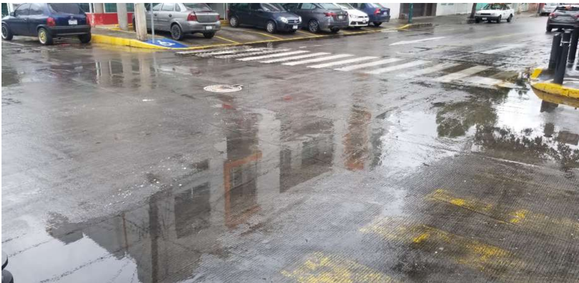
Fotografía 4. Cruce de calles en colonia Félix Ireta tras lluvia, cerca no hay sistema de drenaje para poder evacuar el agua de la superficie.
