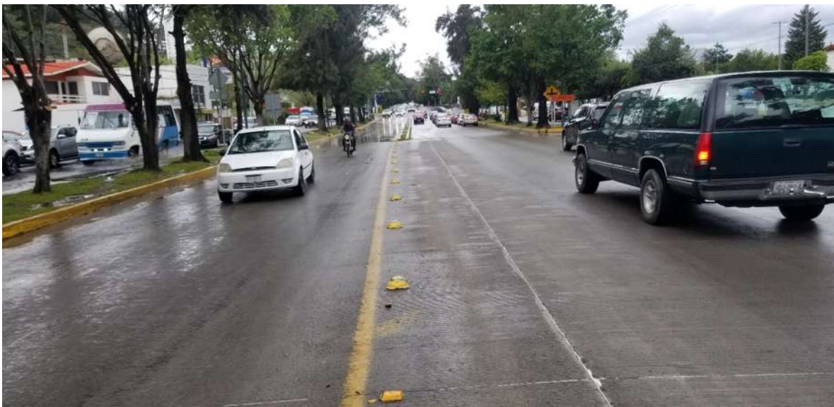
Fotografía 10. Avenida Camelinas (entre colonias Bosque Camelinas y Electricistas) presentó encharcamientos y en algunos puntos inundaciones tras el paso del huracán Willa en 2018.
