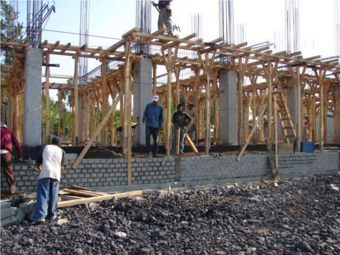
Imagen III.1.- Comienzo de cimbrado para la losa de la primera planta del edificio de la F.C.C.A de la U.M.S.N.H.
