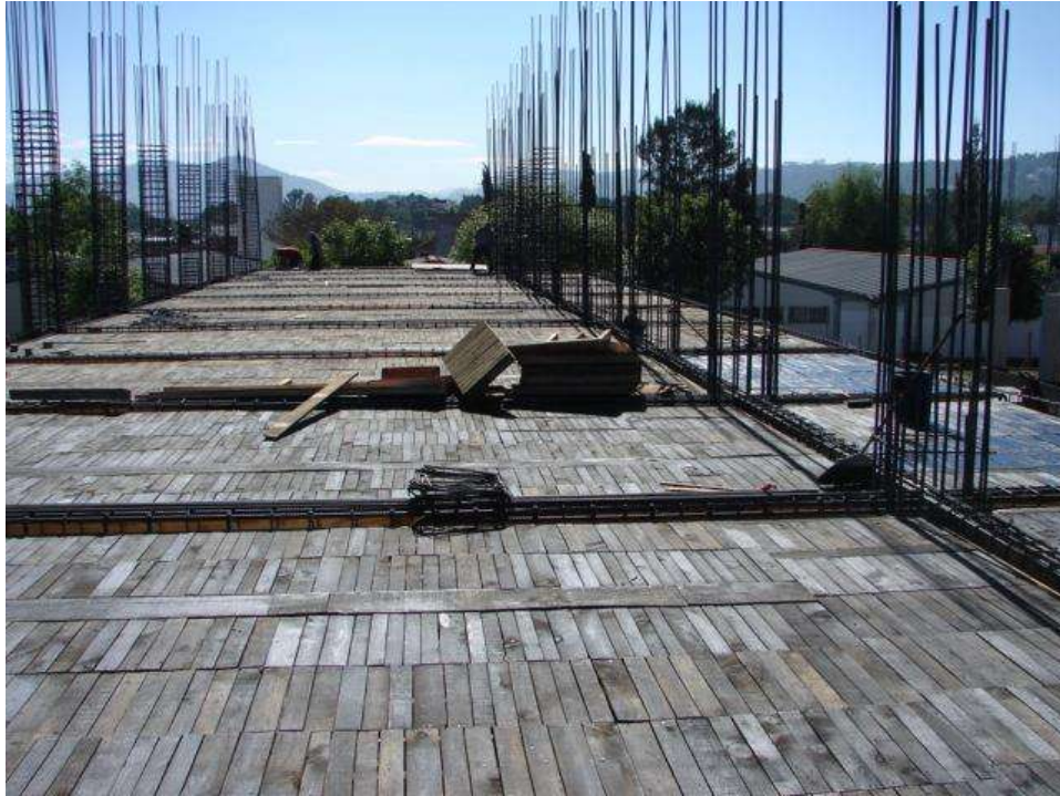
Imagen III.2.- Finalización de cimbrado para la losa de la primera planta del edificio de la F.C.C.A de la U.M.S.N.H.
