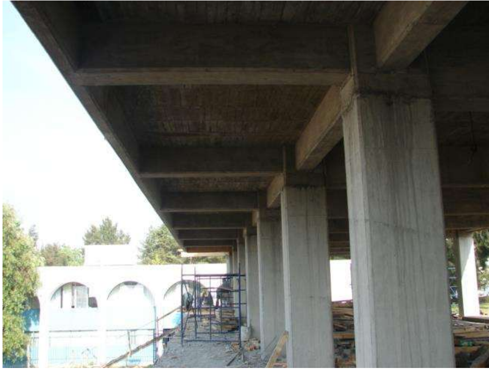
Imagen III.5.- Finalización de construcción de la losa (vista superior) de la primera planta del edificio de la F.C.C.A de la U.M.S.N.H.
