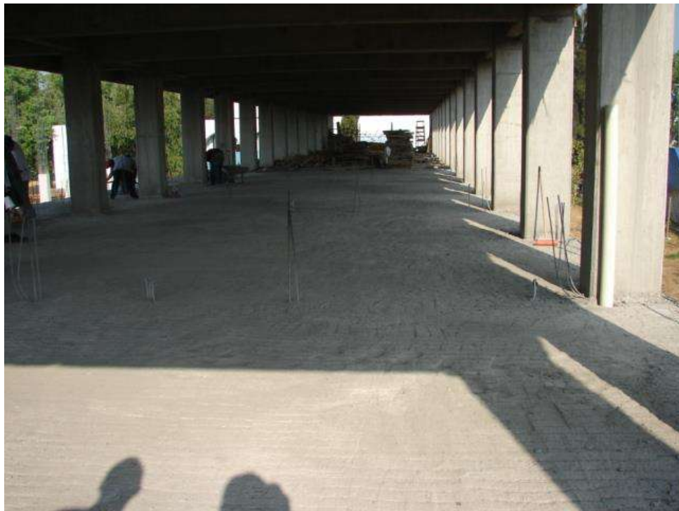
Imagen III.6.- Finalización de construcción de la losa (vista inferior) de la primera planta del edificio de la F.C.C.A de la U.M.S.N.H.
