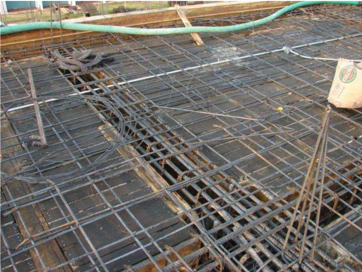
Imagen III.4.- Armado de varilla para “parrilla” empleada en la losa de la primera planta del edificio de la F.C.C.A de la U.M.S.N.H.
