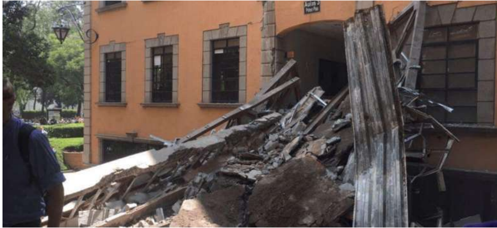
Figura 5.10 Puentes del Tecnológico de Monterrey CCM colapsados después de sismo del 19 de septiembre de 2017. Tomada de https://aristeginoticias.com/2710/kiosko/puentes-mal-construidos-cause-del-colapso-en-el-tec-de-monterrey-y-de-la-muerte-de-5-jovenes-video/
