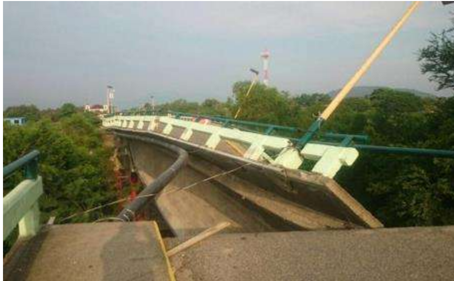
Figura 5.9 Puente que conecta Juchitán con
