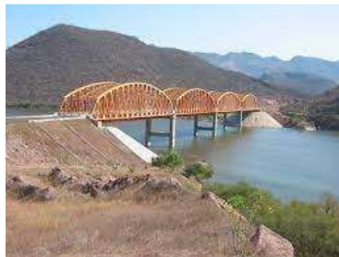
Figura 3.6. Puente Infiernillo. Tomada de https://mapio.net/pic/p-92261882/
