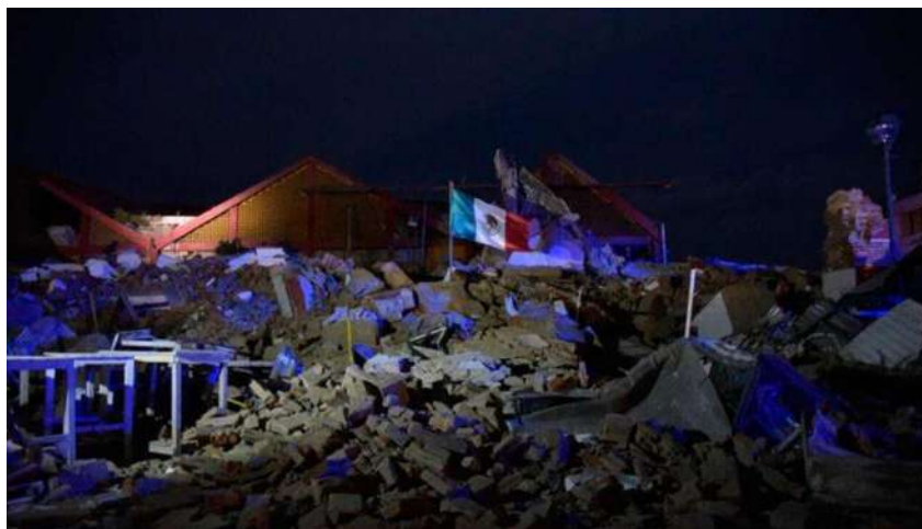
Figura 5.5 Escombros tras el sismo del 7 de septiembre de 2017. Tomada de https://noticieros.televisa.com/historia/sismo-7-de-septiembre-de-2017-oaxaca-mexico-danos/
