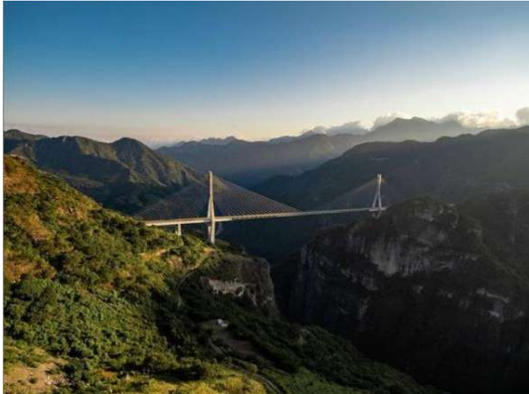
Figura 3.7. Puente Baluarte ubicado en la autopista Durango-Mazatlán. Tomada de https://www.mexicodesconocido.com.mx/puente-baluarte-bicentenario-uno-de-los-mas-altos-del-mundo.html
