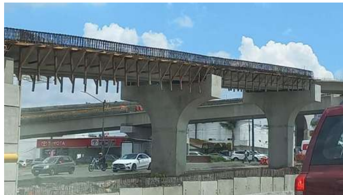
Figura 3.4. Puente tipo viga en construcción en Salida a Mil Cumbres, Morelia. Autoría propia.
