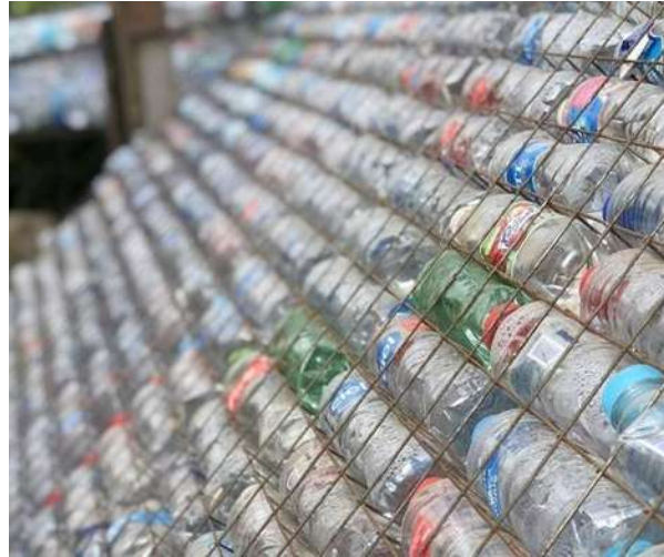
Ilustración 2. Detalle de paneles de PET aligerado. (Plastics Technology México, 2017)
