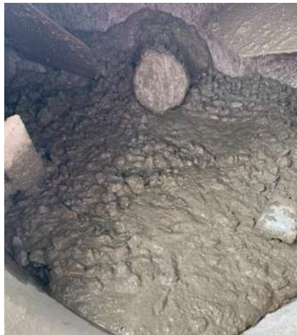
Ilustración 27. Mezcla de concreto en la revolvedora.
