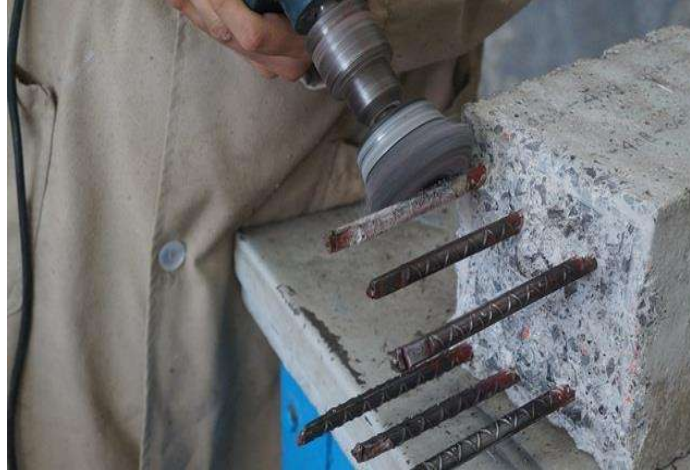
Ilustración 18 Diferencia entre las superficies de barras con y sin el procedimiento de limpieza.
