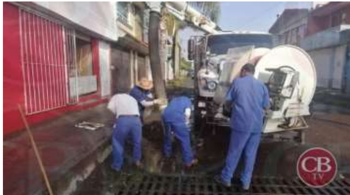
Imagen 37. Desazolve de rejillas pluviales.(Pantoja, 2022)
