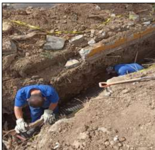
Imagen 13. Reparación de tubería de Alcantarillado.
