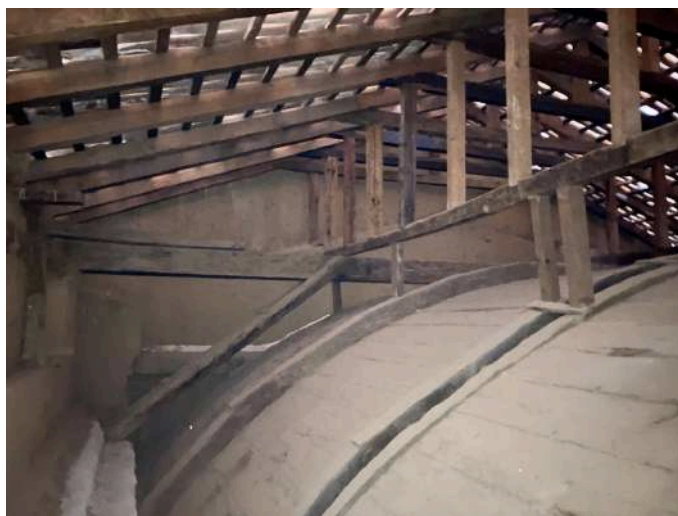
Fig. 53 Interior de la cubierta, muro norte. Fuente: Martínez Cruz, 27.10.21
