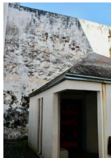
Fig. 20 Instalación de sanitarios. Fuente: Martínez Cruz, 25.01.22
