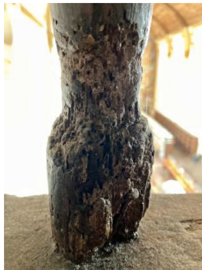
Fig. 57 Parte inferior del balaustre con ataque severo. Fuente: Martínez Cruz, 27.10.21
