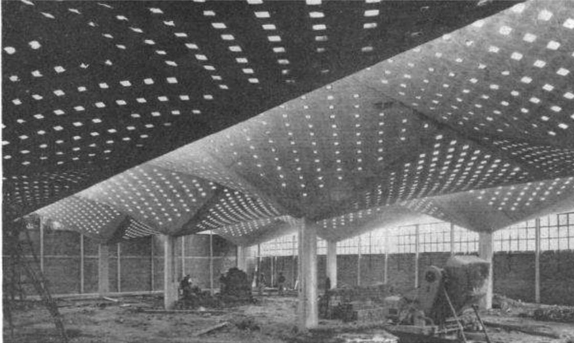
**Fig. 26.** Cubierta fungiforme de la fábrica de vestidos “High Life”, Félix Candela, 1955.
