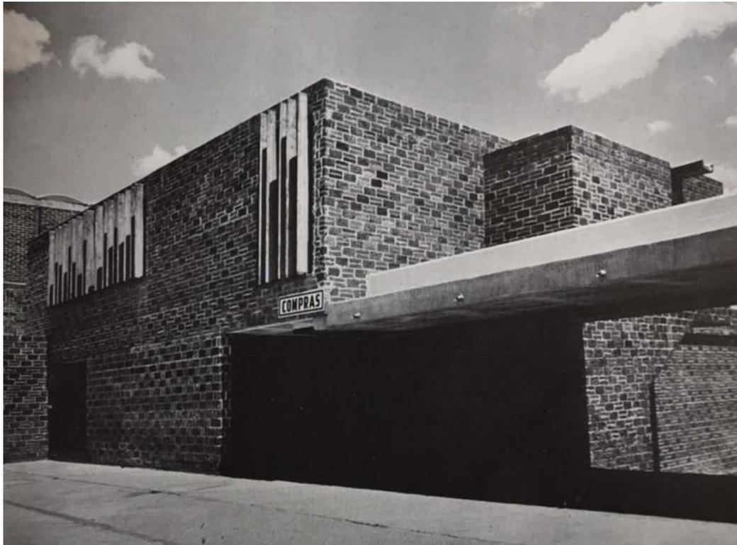
**Fig. 33.** Cuerpo de oficinas las cuales contaban con dos clases de aparejo diferente. Vehículos Automotores Mexicanos, (VAM), México, 1964.
