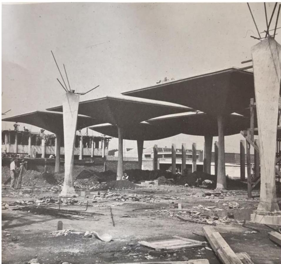
**Fig. 40.** Detalle de los paraguas de concreto durante su construcción.
