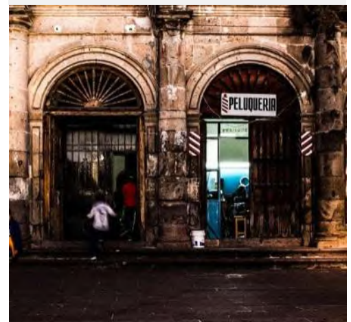
Figura 2.60 Fragmento de la fachada del ex convento de San Agustín, enero 2017. Fuente: Tonantzin Rentería Blanco.
