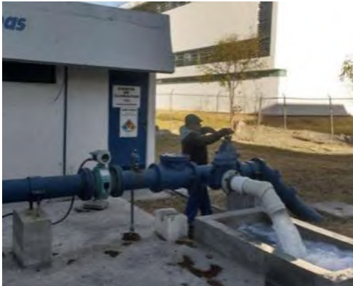
Fig. 03 Imagen. Instalación de agua.
