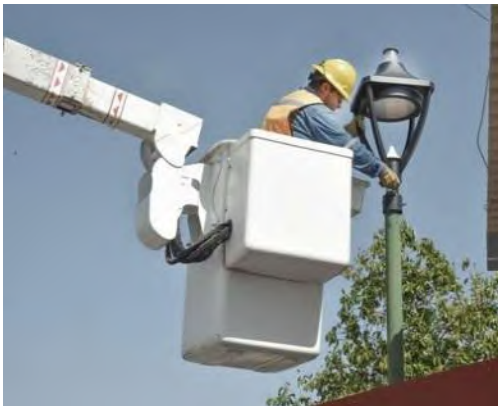
Fig. 04 Imagen. Instalación de electricidad.
