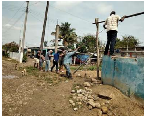
Fig. 06 Imagen. Desabasto de agua.
