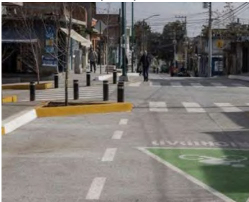
Fig. 05 Imagen. Vialidades pavimentadas.
