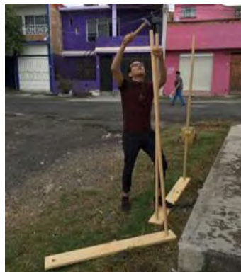
Fig. 109 Imagen. Armado del artefacto urbano en sitio. Tomada por KPS
