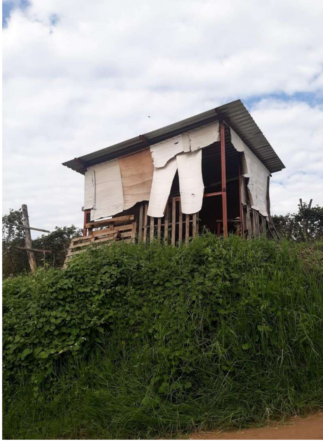
Fig. 00 Especulación con el material aplicado 2. Fuente: Propia
