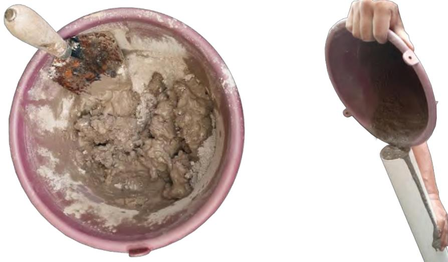
Fig. 430.0 Elaboración de mezcla de concreto con cemento, arena, grava y agua
