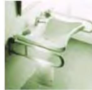
La superficie de aproximación mínima tendrá una profundidad de 1.00m frente al artefacto por un ancho de 0.40m a cada lado del eje del artefacto, que se podrá superponer a las superficies de aproximación de otros artefactos.
