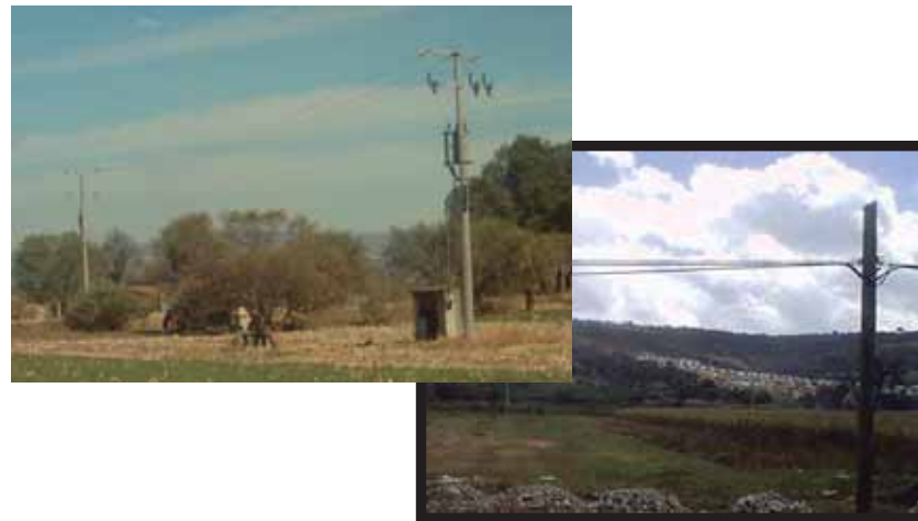
FOTO 05. Infraestructura eléctrica y Telefónica.
