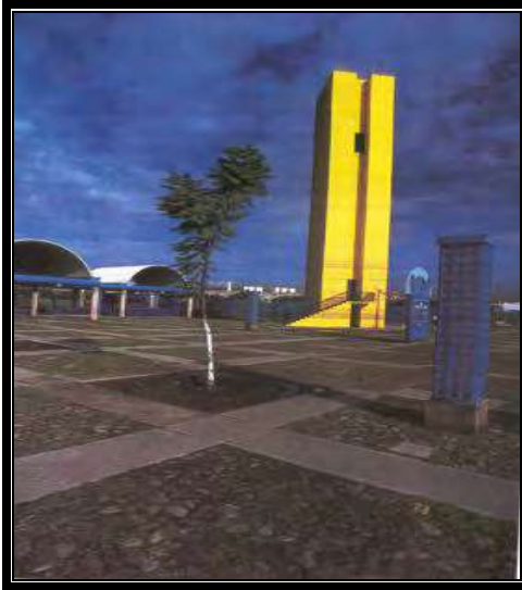
FOTO No. 27.- Plaza de Acceso Parque Recreativo y Cultural el Cedazo Aguascalientes.
