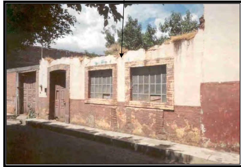
FOTO No. 32.- Vivienda típica de Querendaro.
