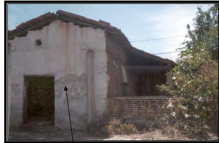
FOTO No. 30.- Vivienda típica de Querendaro.
