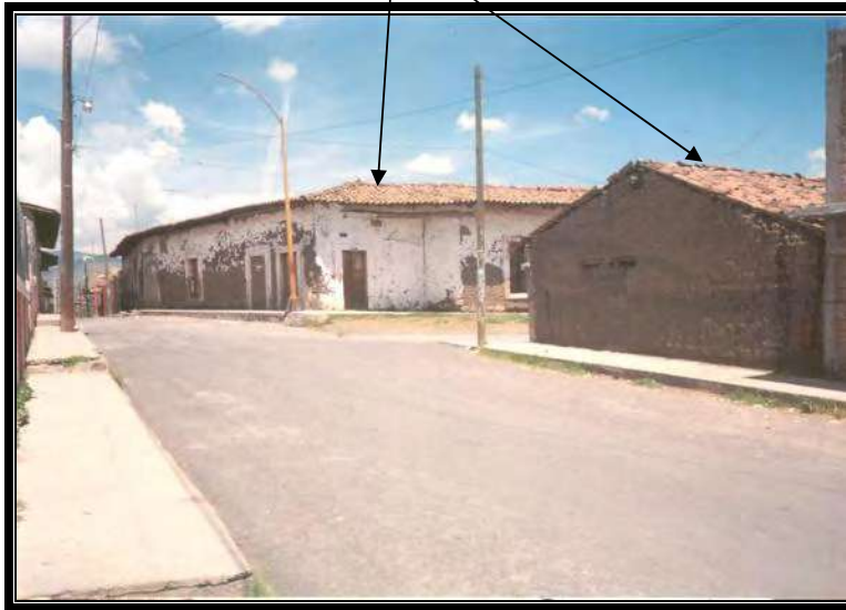
FOTO No. 31.- Vivienda típica de Querendaro.
