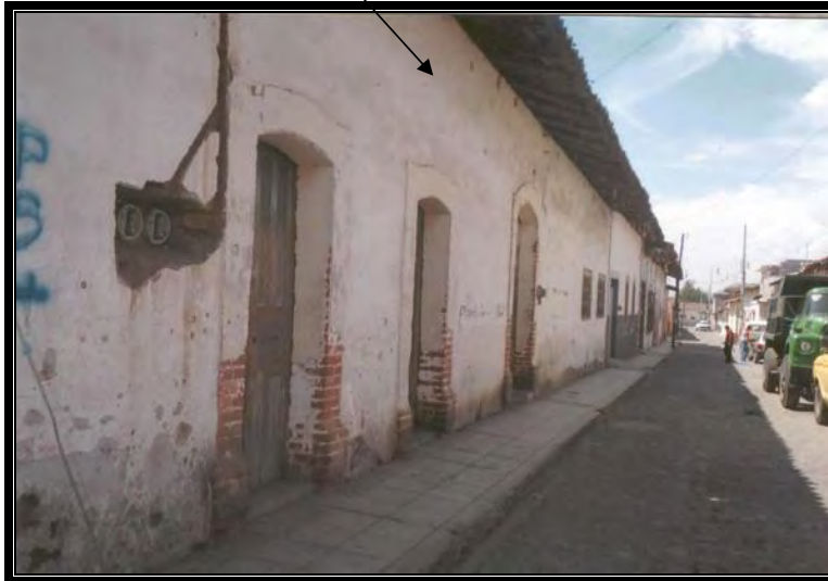
FOTO No. 33.- Vivienda típica de Querendaro.
