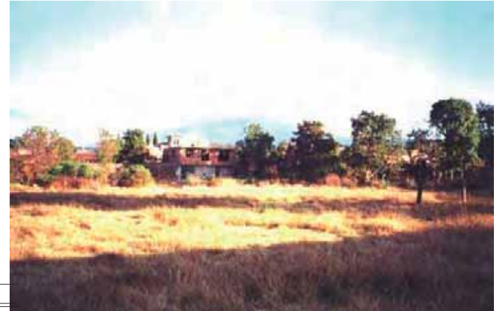
FOTO 2.- VISTA LADO SUR-ESTE
