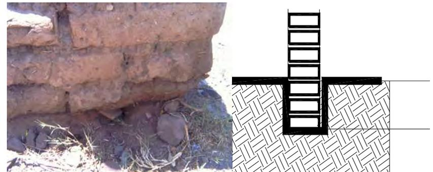
IMAGEN No. 23 Y 24 DETALLE DE DESPLANTE DE MURO DE ADOBE SIN CIMENTACIÓN.
