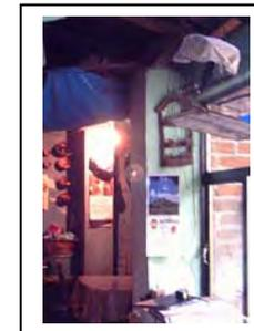
Descripción: los muros son a base de adobe de 14 cms de alto por 40cms de ancho por 40cms de largo, el adobe es asentado con lodo de arcilla y presenta una capa de recubrimiento de cal-arena de aproximadamente 2.5 cms de espesor, estos muros presentan una altura de 2.10 mts, de nivel de piso a tapanco. En cuanto a los apoyos aislados estos están formados por pilares de adobe con un recubrimiento igual al de los muros y se encuentran desplantados sobre un murete de adobe ubicado en el corredor.
