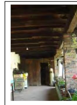
La vivienda presenta muros de adobe asentados con lodo de arcilla, tienen una altura de piso a tapanco de 2.77mts, con un espesor de 30 cms y un aplanado a base de cal arena de 2 cms, de espesor aproximadamente. En cuanto a los apoyos aislados presenta columnas de tabique rojo asentado con cal-arena, estas columnas se desplantan sobre un murete de adobe de 55cms de altura, cabe señalar que las columnas originales de esta vivienda fueron de madera.
