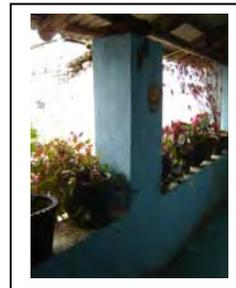
Descripción: la vivienda presenta muros de adobe asentados con lodo de arcilla, aplanados con cal-arena con un espesor de dos cms y con un acabado de pintura a la cal. En cuanto a los apoyos aislados estos se ubican en el pórtico son pilares formados con piezas de adobe de sección rectangular desplantados sobre un murete de adobe.
