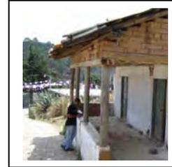
Descripción: Los apoyos continuos están formados por muros de adobe y piedra, donde 1/3 del muro corresponde es de piedra asentada con cal arena esto en la base y 2/3 del muro es de adobe asentado con lodo y de forma traslapada, así mismo presenta una serie de columnillas de madera de 15 cms de diámetro, que se desplantan sobre un murete, estas columnas no presentan zapata.
