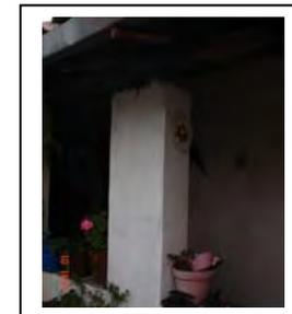
Descripción: la vivienda presenta muros de adobe asentados con lodo de arcilla, aplanados con cal-arena con un espesor de dos cms y con un acabado de pintura a la cal. En cuanto a los apoyos aislados estos son pilares de adobe de sección rectangular con una altura de 2.05 mts, y presenta el mismo recubrimiento que los muros.
