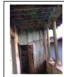
Descripción: los muros están formados a base de piezas de adobe asentados con lodo de arcilla, presentan un recubrimiento de cal-arena de dos cms de espesor con un acabado de pintura a la cal. En cuanto a los apoyos aislados estos son columnas de madera de sección octogonal las cuales se desplanta sobre un murete de adobe.
