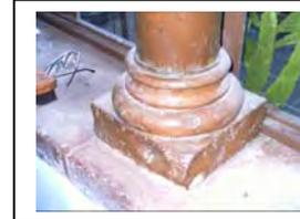
Descripción: la vivienda presenta muros formados a base de piezas de adobe asentados con lodo de arcilla, aplanados con cal-arena con un espesor de dos cms y con un acabado de pintura a la cal. En cuanto a los apoyos aislados estos son columnas de madera de 15 cms, de diámetro y el la parte superior presentan una zapata tallada en madera se desplanta sobre un murete de adobe.
