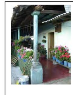
Presenta muros de adobe asentados con lodo de arcilla, tienen una altura de piso a tapanco de 3.26 mts, con un espesor de 54 cms y un aplanado a base de cal arena de 2 cms, de espesor aproximadamente. En cuanto a los apoyos aislados presenta columnas de madera de 16 cms de diámetro, con una zapata tallada en madera, estas columnas se desplantan sobre un murete de adobe de 40cms de altura.
