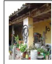
Descripción: los muros que presenta esta vivienda son a base de piezas de adobe asentados con lodo de arcilla, tienen un espesor de 34 cm, con una altura de piso a tapanco de 2.80 mts, estos muros presentan un recubrimiento de cal-arena de dos cm, de espesor. en cuanto a los apoyos aislados estos son columnas de tabique rojo recocado asentadas con las arena y aplanadas con cal-arena.
