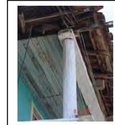
Descripción: los muros que presenta esta vivienda son de una altura de piso a tapanco de 1.81cms, a base de piezas de adobe asentados con lodo de arcilla y recubiertos por los costados con una capa de cal - arena de aproximadamente dos centímetros de espesor. En lo que respecta a los apoyos aislado estos se ubican únicamente en la planta alta en los balcones estos apoyos son de madera con un diámetro de aproximadamente 12 cms de diámetro y una altura de 1.90 mts.
