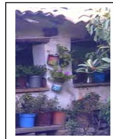
Descripción: los muros están formados con adobes de sección 10x30x50 cms, estos adobes son asentados con lodo de arcilla de foma cuatropada, presentan un recubrimiento con cal-arena de aproximadamente dos cms, de espesor con un acabado de pintura a la cal. En el caso de los apoyos aislados estos presentan los mismos materiales, estos presentan una sección rectangular de 32x52 cms, y una altura de aproximadamente 90cms, estos se desplantan sobre un murete de aproximadamente 80cms, de altura.
