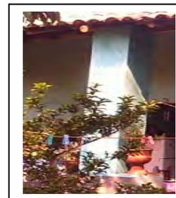
Descripción: en el caso de esta vivienda los muros están formados con adobes de sección 10x40x50 cms, estos adobes son asentados con lodo de arcilla de forma cuatrapeada. Por otro lado estos muros presentan un recubrimiento con cal-arena de aproximadamente dos cms, de espesor. En cuanto a los apoyos aislados estos presentan una sección rectangular de 55x55 cms, y una altura de aproximadamente 2.7mts, estos están formados a base de adobe desplantados sobre un murete.
