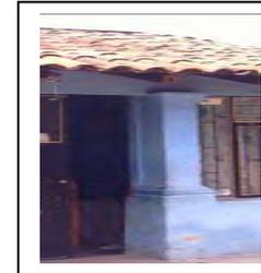
Descripción: en este caso los muros están formados con adobes de sección 10x35x50 cms, estos adobes son asentados con lodo de arcilla de forma cuatropuada, estos muros presentan un recubrimiento con cal-arena de aproximadamente dos cms, de espesor. En cuanto a los apoyos aislados estos presentan una sección rectangular de 28xcms, y una altura de aproximadamente 2.7mts, estos están actualmente formados con tabique rojo recocido, y posiblemente los originales fueron elaborados con adobe
