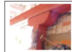
Descripción: en el caso de esta vivienda presenta muros de adobe de 36cm de espesor asentados con lodo de arcilla, aplanados con cal-arena con un espesor de dos cms y con un acabado de pintura a la cal. Por otro lado los apoyos aislados estos se ubican en el pórtico son de madera de sección cuadrada desplantados sobre una base de piedra.
