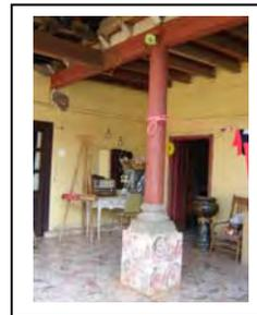
La vivienda presenta muros de adobe asentados con lodo de arcilla, tienen una altura de piso a tapanco de 2.68mts, con un ancho de 30 cms y un aplanado a base de cal arena de 2 cms. En cuanto a los apoyos aislados presenta columnas de madera de 20 cms de diámetro cabe señalar que estas columnas no presentan zapata alguna por lo que descansa inmediatamente sobre ellas el arrastre inferior.
