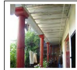
Presenta muros a base de adobe, asentados con arcilla, recubiertos por una capa de cal-arena de aproximadamente dos centímetros de espesor y pintados con cal, y un muro de contención a base de piedra braza de la región asentada con cal-arena y repellado con este mismo material. Dentro de lo que son los apoyos se encuentra una serie de columnatas de madera, en la planta baja, estas columnas redondas llevan en la parte superior una zapata de madera.
