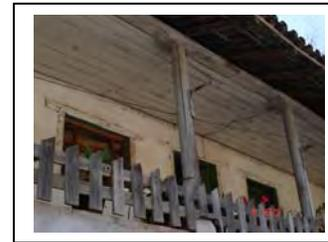
Los muros son a base de adobe, asentados con arcilla, recubiertos por una capa de arcilla de aproximadamente dos centímetros de espesor y pintados con cal. Dentro de los apoyos se encuentra una serie de columnatas de madera, que en la parte superior presentan cada una, una zapata de madera misma que funciona para transmitir uniformemente las cargas de la cubierta a través de las columnillas hasta llegar a la cimentación.
