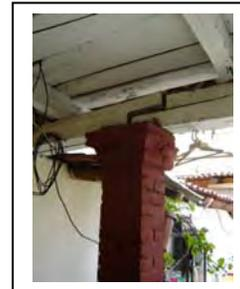
Descripción: los muros son a base de piezas de adobe asentados con lodo de arcilla, estos muros presentan un recubrimiento de cal-arena de dos cm, de espesor .en cuanto a los apoyos aislados estos son columnas de tabique rojo recocido asentadas con cal-arena.
