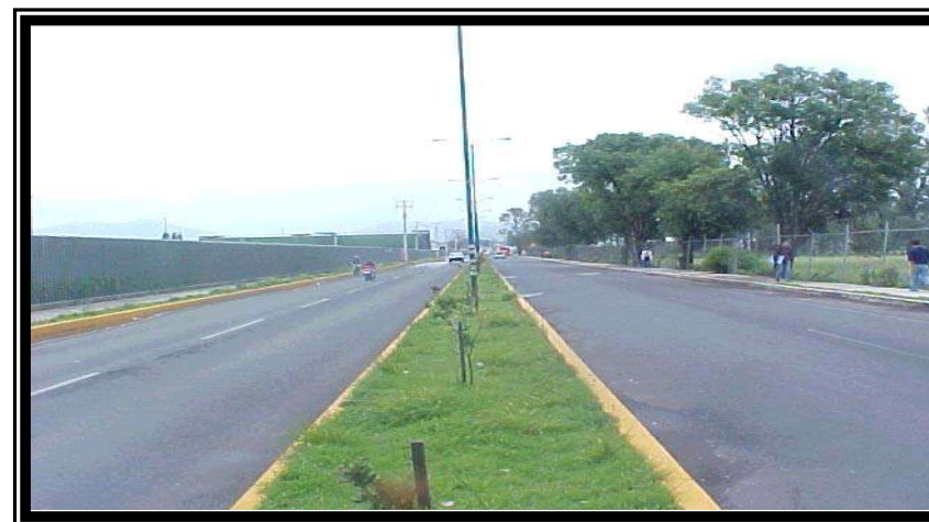
Fig.10. En la Av. Universidad hay encarpetado asfáltico en condiciones relativamente buenas en ambos carriles y banquetas de concreto de 1.5 m de ancho en ambos lados y en el carril Oriente poniente se aprecia la existencia de guarniciones para la ubicación de vegetación
