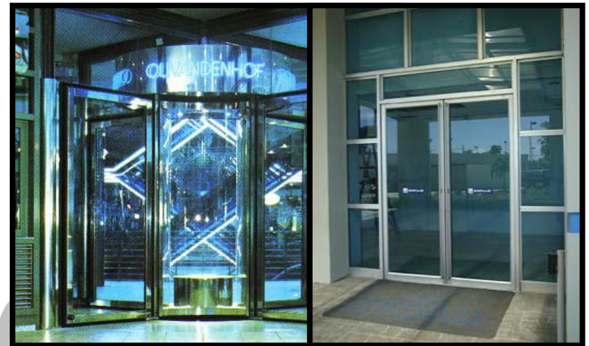
Fig. 5.6. Puertas automáticas, mantienen la temperatura del interior aislada del exterior por su mecanismo de cierre automático cuando es requerido.
