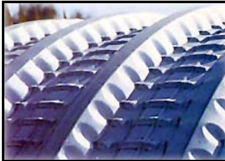
Fig. 5.7. Chapa BC35 curvada, mediante pliegues transversales en forma convexa
