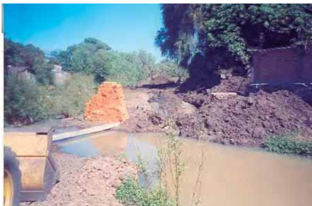
11.- VISTA DEL ARRIYO IZTINGUARORITOI EN EL TRAMO SUR DEL CENTRO DE POBLACION
