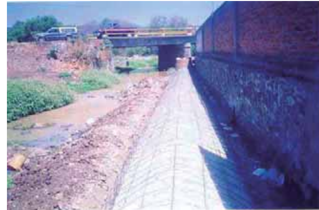
18.- VISTA DE LA CONSTRUCCIÓN DEL COLECTOR MARGINAL EN EL TRAMO ORIENTE JUNTO AL ARROYO
