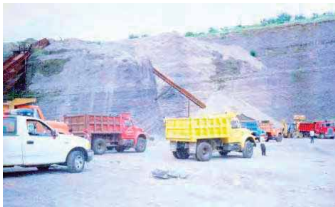
16.- EXTRACCIÓN DE GRAVA Y ARENA EN EL MANCO DE MATERIAL DE TIRIMACUARO
