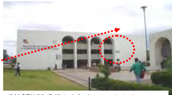
IMAGEN 52: Edificio A-2, Acceso principal
