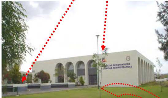
IMAGEN 55: Edificio A Acceso principal
