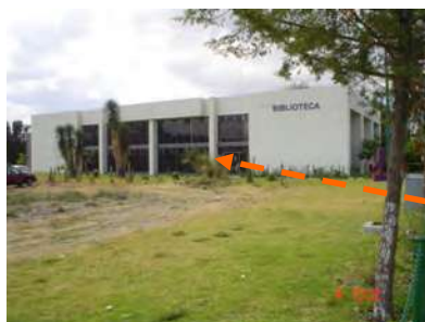
IMAGEN 78: Fachada de la biblioteca.
