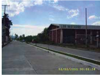
Foto 72 Calle Cananea, vialidad y acceso principal del terreno por el lado Oeste
