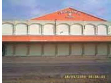
Foto 84 Disco Casa Blanca ubicada en la Av. Latinoamericana.
