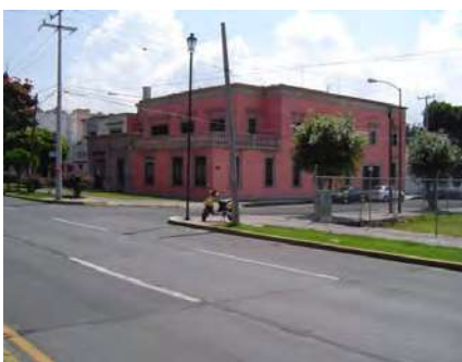
En la esquina de la fachada norte se aprecian dos postes
