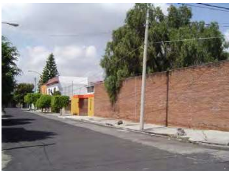
Vista del terreno lado Sur, colinda con la calle Batallón Morelos
