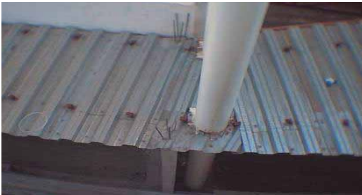
Imagen 030: elementos tubulares de acero vigas metálicas
