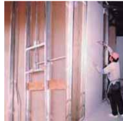
Imagen 033: Es un material que se instala totalmente en seco y constituye una excelente barrera contra el fuego, debido al núcleo de yeso, que es un mineral que no se quema.
