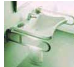
Imagen 048: se muestra la manera que debe de diseñarse el lavabo para uso exclusivo para discapacitados.
