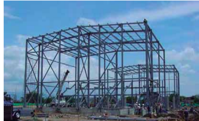
Imagen 028: estructura de acero salas de cine
