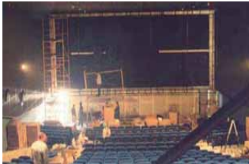
Imagen 070: construcción de una sala de proyección
