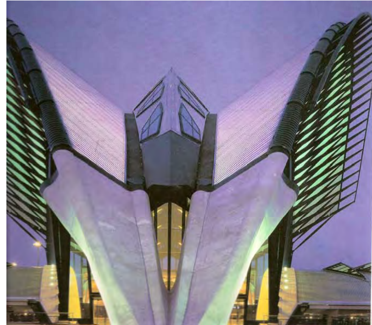
IMAGEN 33 Estacion del TGV en el aeropuerto de Lyon Arq. Santiago Calatrava
