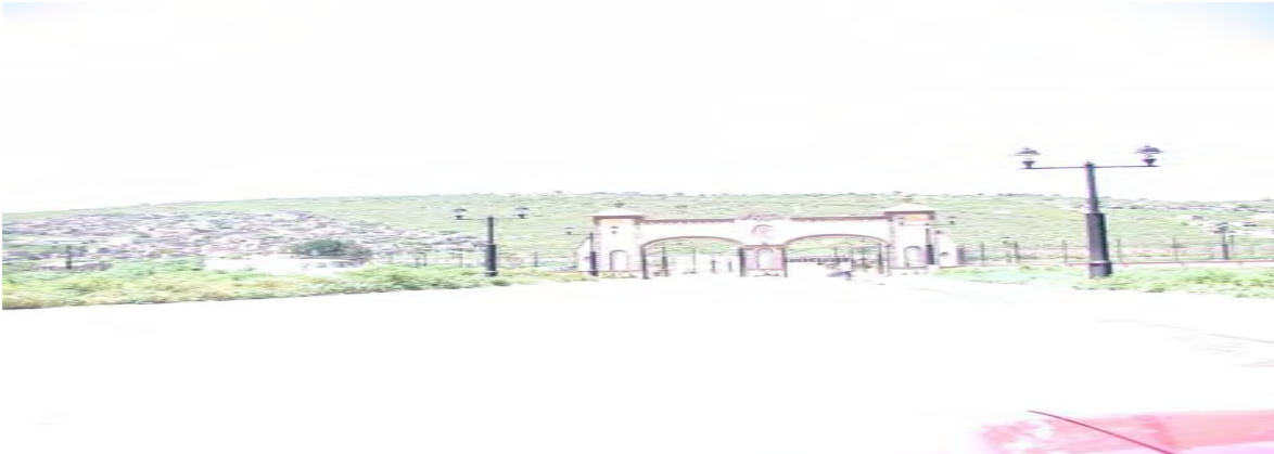
IMAGEN 90 Vista del terreno propuesto que se encuentra ubicado en la imagen en el lado izquierdo quedando el terreno en esquina. PROYECTO: CONJUNTO DE TERRAZAS PARA EVENTOS SOCIALES
